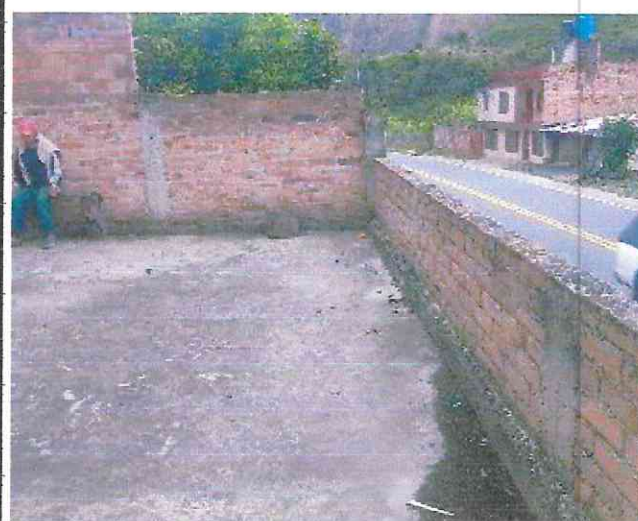
ZONA DURA - MURO EN LADRILLO
