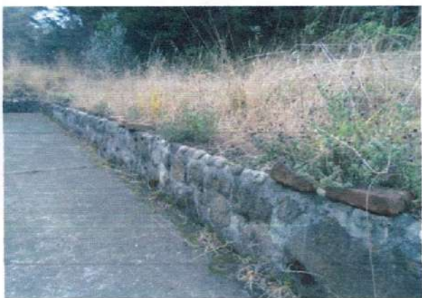
A 2 MURO EN PIEDRA
