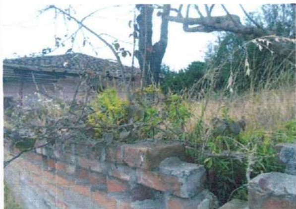
A 3 MURO EN LADRILLO
