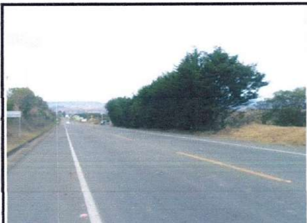
VISTA NORTE SUR
