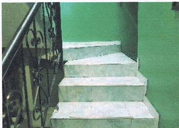
ESCALERAS A 3° PISO , TERRAZA. CONST. 1
