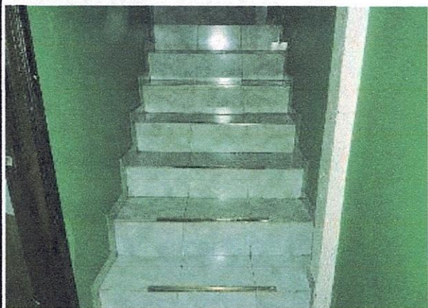
ESCALERAS A 2º PISO, CONST. 1
