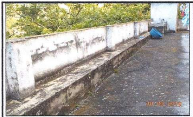
A5, A12, A14 - MURO 1, BANCA Y ZONA DURA 1
