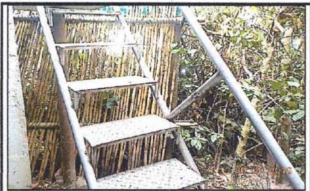
C3 - ESCALERA METALICA
