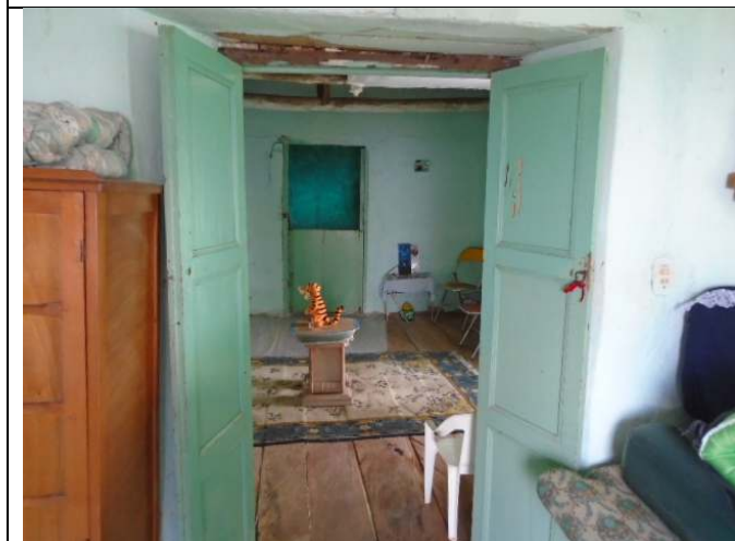
C3: Construcción – Vista interna
