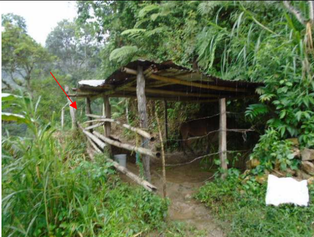
M2: Cerramiento y M3: Enramada
