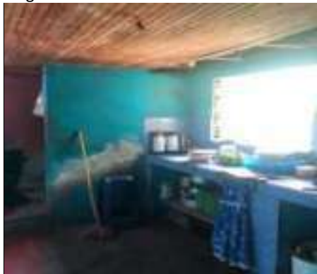
Descripcion Cocina y Cielo raso
