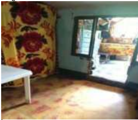
Descripcion piso y puerta ventana
