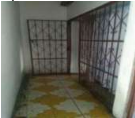
Descripcion piso - reja
