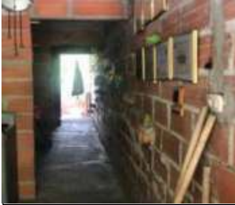
Descripcion paredes y piso
