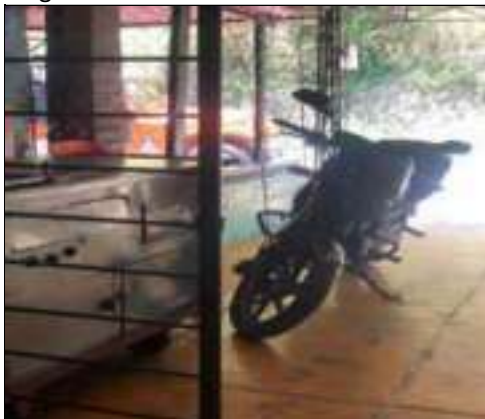
Descripcion rejas y piso
