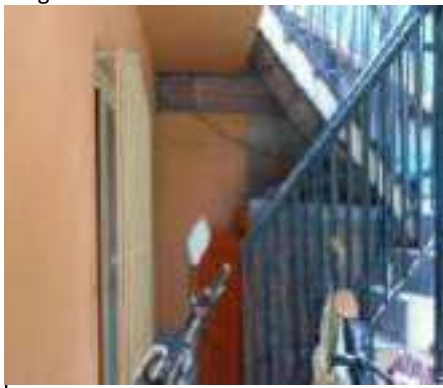
Descripcion ESCALERA EXTERIOR
