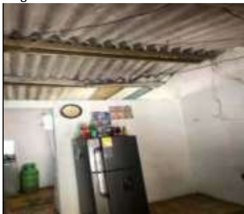
Descripcion TECHO INTERNO
