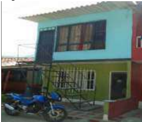
Descripcion fachada primer piso
