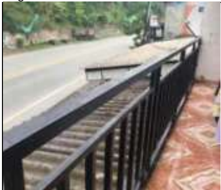
Descripcion BARANDA Y PISO
