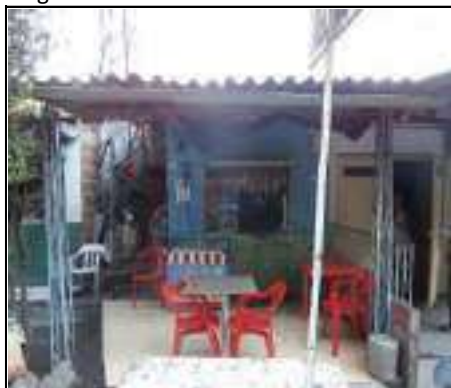
Descripcion fachada- techo
