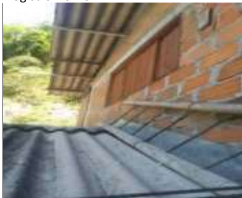
Descripcion fachada lateral interna
