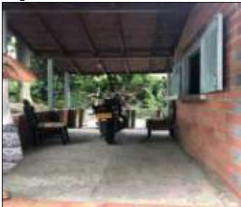
Descripcion zona dura cielo raso
