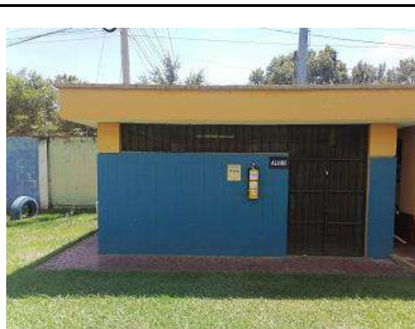
VISTA PARCIAL ALJIBE
