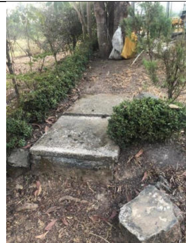
Bx – Cajas de inspección
