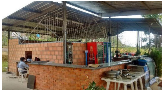
Vista parcial C1- Construcción
