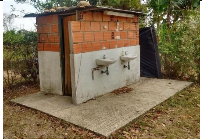
C2- Construcción- Zd3 Andenes
