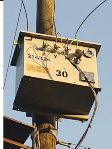
Ps – Poste - detalle
