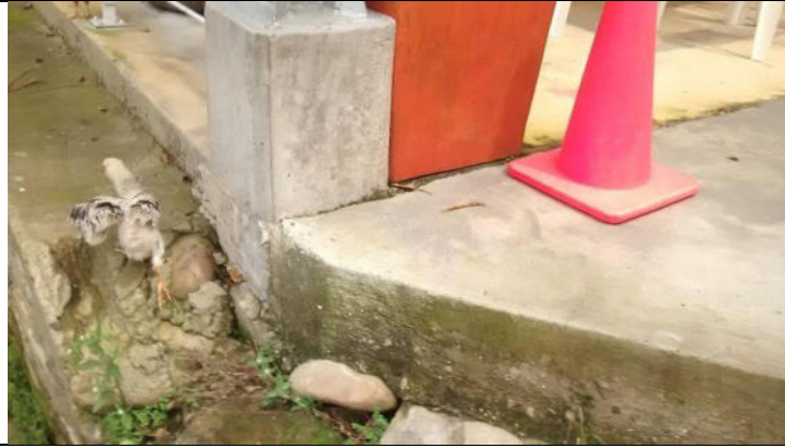
Be – Pilotes de anclaje
