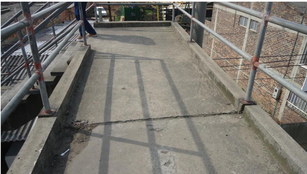
Fotografía No 3. Presencia de fisuras y deterioro placa peatonal
