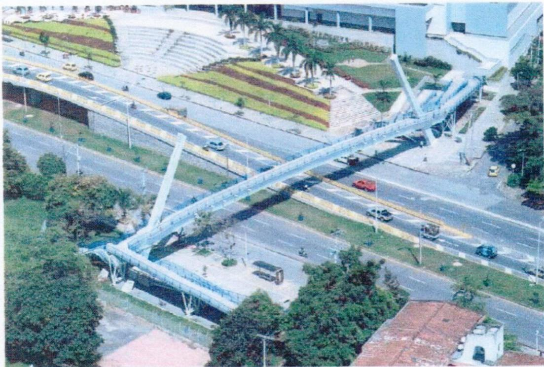
La solución peatonal localizada sobre la Autopista Sur (Calle 10) - Carrera 68, contempla la construcción de un puente a desnivel, librando toda la Autopista Sur (Calle 10), con rampas de acceso, así como escaleras a cada lado, barandas metálicas.
