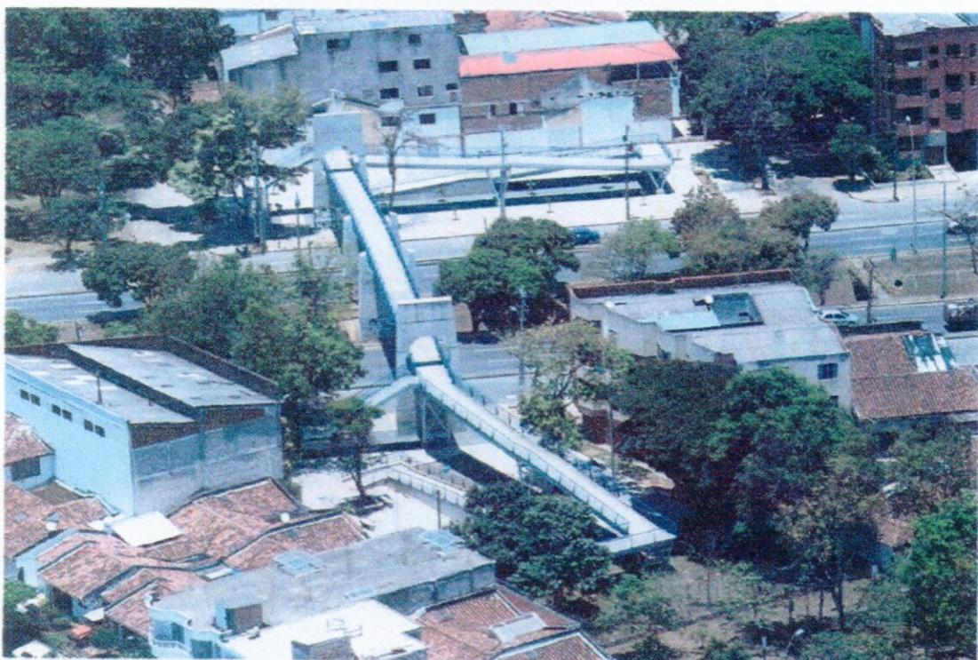
La solución peatonal localizada sobre la Autopista Sur (Calle 10) - Carrera 63B, contempla la construcción de un puente a desnivel, librando toda la Autopista Sur (Calle 10), con rampas de acceso, así como escaleras a cada lado, barandas metálicas.
