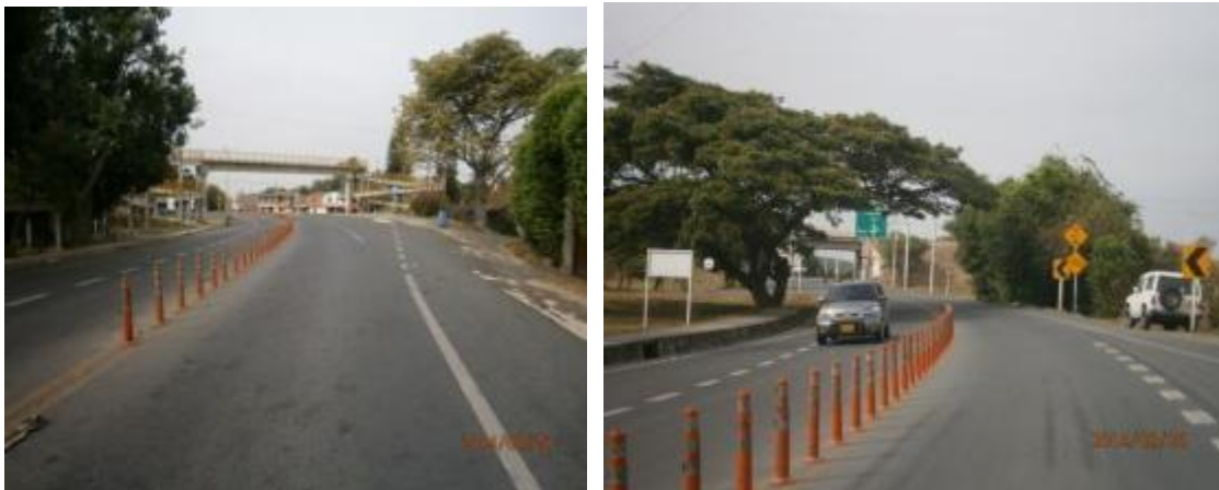
Elementos de protección. Hitos existentes separador Señaliz. Horizontal y vertical Conexión Rozo – La Torre Tramo 6.
