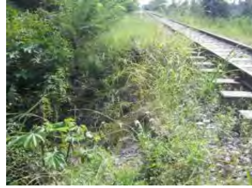
IMÁGENES DEL HUNDIMIENTO DEL TERRAPLÉN FERROVIARIO POR DEFORMACIÓN DE LA SUBRASANTE PK 0288 + 320 EN EL SECTOR COMPRENDIDO ENTRE PUERTO TRIUNFO-NARE
