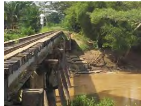
IMÁGENES DE LA SOCAVACIÓN DE ESTRIBOS EN PUENTES PK 0423 + 895 EN EL SECTOR COMPRENDIDO ENTRE GRECIA-CABAÑAS
