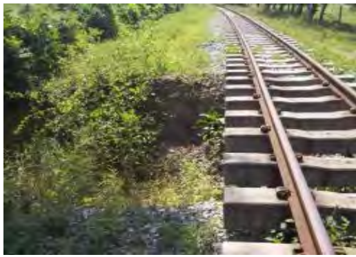
IMÁGENES DEL HUNDIMIENTO DEL TERRAPLÉN FERROVIARIO POR DEFORMACIÓN DE LA SUBRASANTE PK 0235 + 540 EN EL SECTOR COMPRENDIDO ENTRE LA DORADA-PUERTO TRIUNFO
