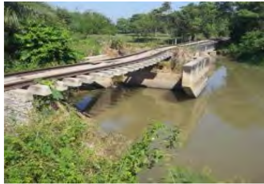
IMÁGENES DEL SOCAVACIÓN DE ESTRIBOS EN PUENTES PK 0678 + 160 EN EL SECTOR COMPRENDIDO ENTRE GAMARRA-CHIRIGUANÁ
