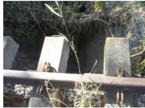
IMÁGENES DEL HUNDIMIENTO DEL TERRAPLÉN FERROVIARIO POR DEFORMACIÓN DE LA SUBRASANTE PK 0638 + 160 EN EL SECTOR COMPRENDIDO ENTRE GAMARRA-CHIRIGUANÁ
