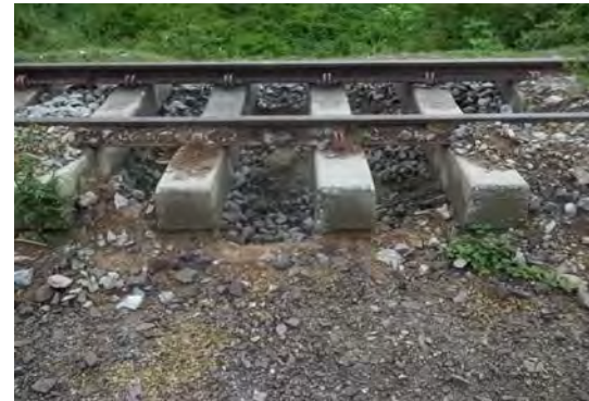
IMÁGENES DEL HUNDIMIENTO DEL TERRAPLÉN FERROVIARIO POR DEFORMACIÓN DE LA SUBRASANTE PK 0721 + 750 EN EL SECTOR COMPRENDIDO ENTRE GAMARRA-CHIRIGUANÁ
