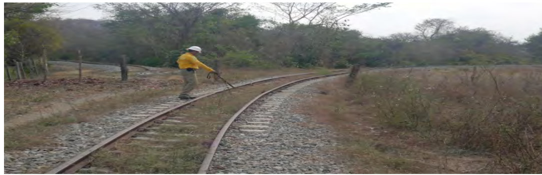
IMÁGENES DEL SUMINISTRO DE CAMBIA-VÍAS NUEVO PK 598+470 AL 598+520 EN EL SECTOR COMPRENDIDO ENTRE RAMAL PUERTO CAPULCO
