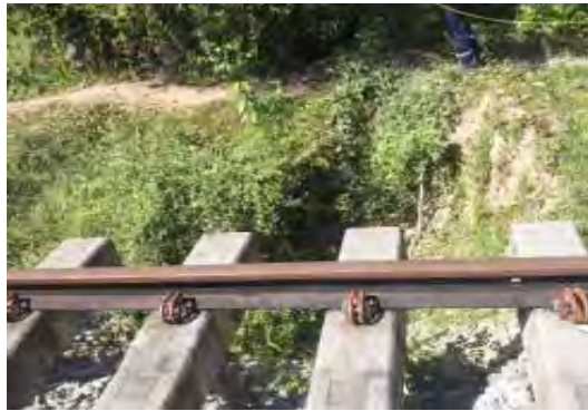
IMÁGENES DEL HUNDIMIENTO DEL TERRAPLÉN FERROVIARIO POR DEFORMACIÓN DE LA SUBRASANTE PK 0678 + 500 EN EL SECTOR COMPRENDIDO ENTRE GAMARRA-CHIRIGUANÁ
