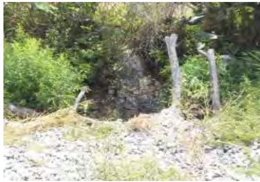
IMÁGENES DEL HUNDIMIENTO DEL TERRAPLÉN FERROVIARIO POR DEFORMACIÓN DE LA SUBRASANTE PK 0506 + 950 EN EL SECTOR COMPRENDIDO ENTRE BARRANCABERMEJA-SAN RAFAEL
