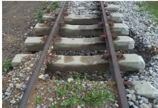
IMÁGENES DEL HUNDIMIENTO DEL TERRAPLÉN FERROVIARIO POR DEFORMACIÓN DE LA SUBRASANTE PK 0721 + 750 EN EL SECTOR COMPRENDIDO ENTRE GAMARRA-CHIRIGUANÁ
