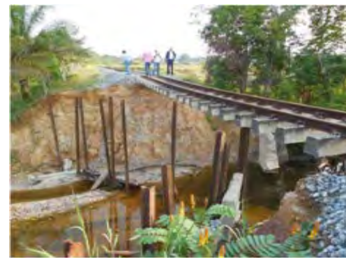
IMÁGENES DEL HUNDIMIENTO DEL TERRAPLÉN FERROVIARIO POR DEFORMACIÓN DE LA SUBRASANTE PK 0479 + 000 EN EL SECTOR COMPRENDIDO ENTRE BARRANCABERMEJA-SAN RAFAEL
