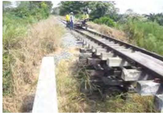
IMÁGENES DE LA SOCAVACIÓN DE ESTRIBOS EN PUENTES PK 0513 + 599 EN EL SECTOR COMPRENDIDO ENTRE BARRANCABERMEJA-SAN RAFAEL
