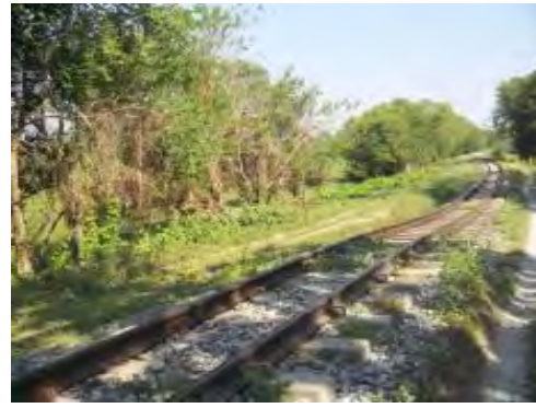
IMÁGENES DEL HUNDIMIENTO DEL TERRAPLÉN FERROVIARIO POR DEFORMACIÓN DE LA SUBRASANTE PK 0300 + 249 EN EL SECTOR COMPRENDIDO ENTRE NARE-GRECIA
