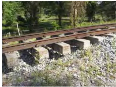
IMÁGENES DEL HUNDIMIENTO DEL TERRAPLÉN FERROVIARIO POR DEFORMACIÓN DE LA SUBRASANTE PK 0299 + 200 EN EL SECTOR COMPRENDIDO ENTRE NARE-GRECIA
