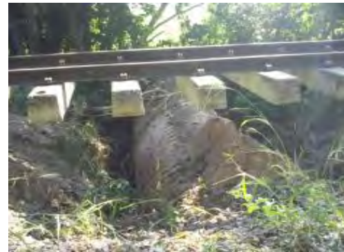
IMÁGENES DEL HUNDIMIENTO DEL TERRAPLÉN FERROVIARIO POR DEFORMACIÓN DE LA SUBRASANTE PK 0674 + 902 EN EL SECTOR COMPRENDIDO ENTRE GAMARRA-CHIRIGUANÁ
