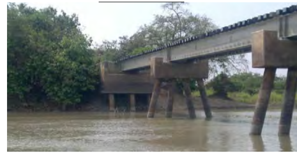
IMÁGENES DEL SOCAVACIÓN DE ESTRIBOS EN PUENTES PK 601+427 AL 601+473 EN EL SECTOR COMPRENDIDO ENTRE RAMAL PUERTO CAPULCO
