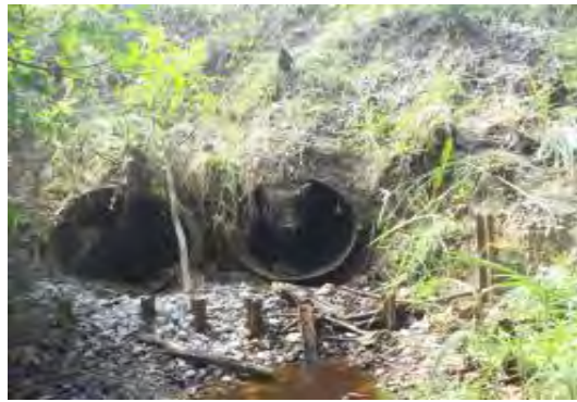
IMÁGENES DEL HUNDIMIENTO DEL TERRAPLÉN FERROVIARIO POR DEFORMACIÓN DE LA SUBRASANTE PK 0288 + 320 EN EL SECTOR COMPRENDIDO ENTRE PUERTO TRIUNFO-NARE
