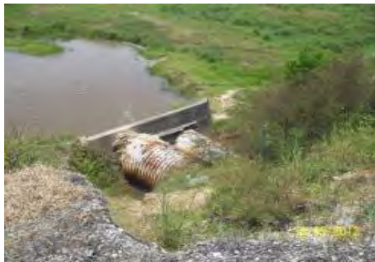
IMÁGENES DEL HUNDIMIENTO DEL TERRAPLÉN FERROVIARIO POR DEFORMACIÓN DE LA SUBRASANTE PK 0451 + 720 EN EL SECTOR COMPRENDIDO ENTRE BARRANCABERMEJA-SAN RAFAEL
