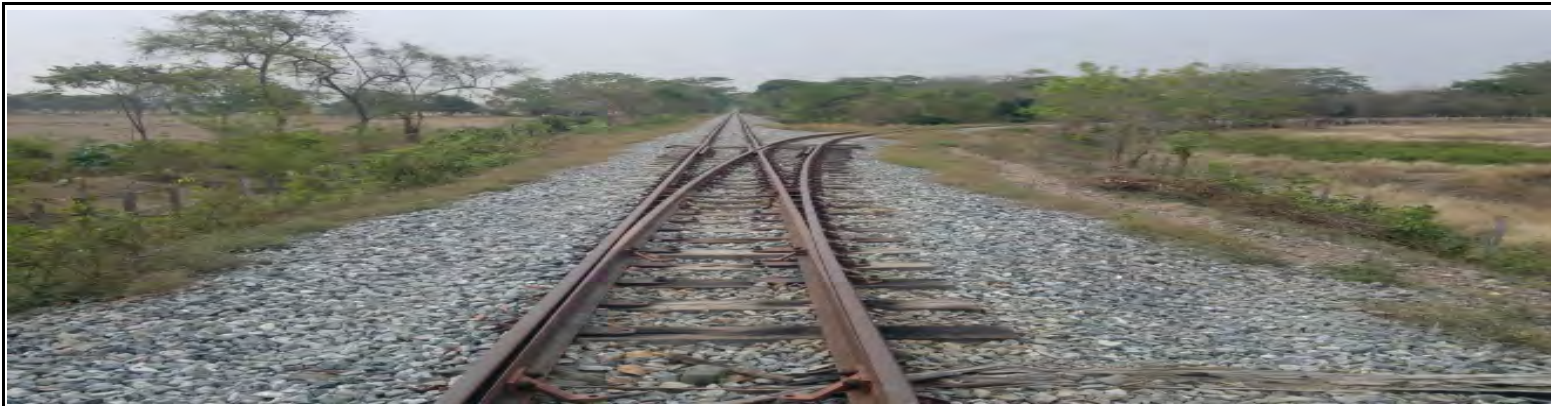
SECCIÓN TÍPICA: SUMINISTRO DE CAMBIA-VÍAS NUEVO - CV
