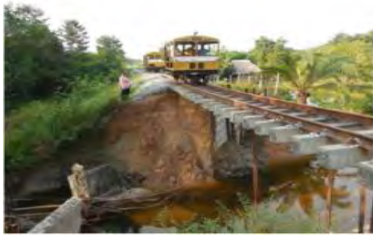
IMÁGENES DEL HUNDIMIENTO DEL TERRAPLÉN FERROVIARIO POR DEFORMACIÓN DE LA SUBRASANTE PK 0479 + 000 EN EL SECTOR COMPRENDIDO ENTRE BARRANCABERMEJA-SAN RAFAEL
