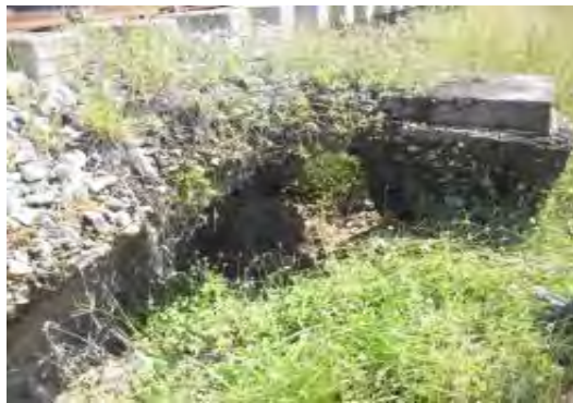
IMÁGENES DEL HUNDIMIENTO DEL TERRAPLÉN FERROVIARIO POR DEFORMACIÓN DE LA SUBRASANTE PK 0276 + 155 EN EL SECTOR COMPRENDIDO ENTRE PUERTO TRIUNFO-NARE
