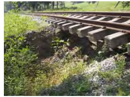
IMÁGENES DEL HUNDIMIENTO DEL TERRAPLÉN FERROVIARIO POR DEFORMACIÓN DE LA SUBRASANTE PK 0235 + 540 EN EL SECTOR COMPRENDIDO ENTRE LA DORADA-PUERTO TRIUNFO
