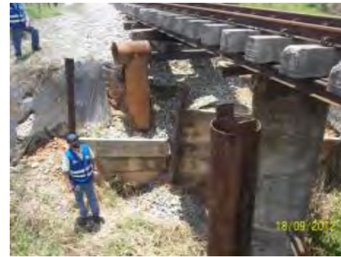
IMÁGENES DEL HUNDIMIENTO DEL TERRAPLÉN FERROVIARIO POR DEFORMACIÓN DE LA SUBRASANTE PK 0451 + 720 EN EL SECTOR COMPRENDIDO ENTRE BARRANCABERMEJA-SAN RAFAEL
