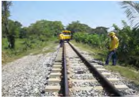
IMÁGENES DEL HUNDIMIENTO DEL TERRAPLÉN FERROVIARIO POR DEFORMACIÓN DE LA SUBRASANTE PK 0312 + 593 EN EL SECTOR COMPRENDIDO ENTRE NARE-GRECIA
