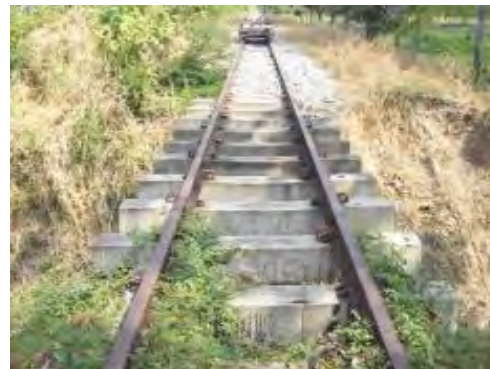
IMÁGENES DEL HUNDIMIENTO DEL TERRAPLÉN FERROVIARIO POR DEFORMACIÓN DE LA SUBRASANTE PK 0511 + 254 EN EL SECTOR COMPRENDIDO ENTRE BARRANCABERMEJA-SAN RAFAEL
