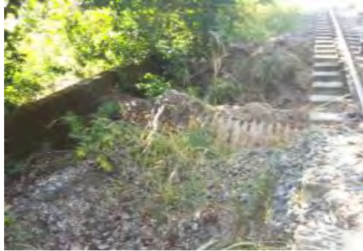
IMÁGENES DEL HUNDIMIENTO DEL TERRAPLÉN FERROVIARIO POR DEFORMACIÓN DE LA SUBRASANTE PK 0674 + 902 EN EL SECTOR COMPRENDIDO ENTRE GAMARRA-CHIRIGUANÁ
