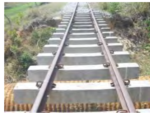
IMÁGENES DEL HUNDIMIENTO DEL TERRAPLÉN FERROVIARIO POR DEFORMACIÓN DE LA SUBRASANTE PK 0514 + 800 EN EL SECTOR COMPRENDIDO ENTRE BARRANCABERMEJA-SAN RAFAEL
