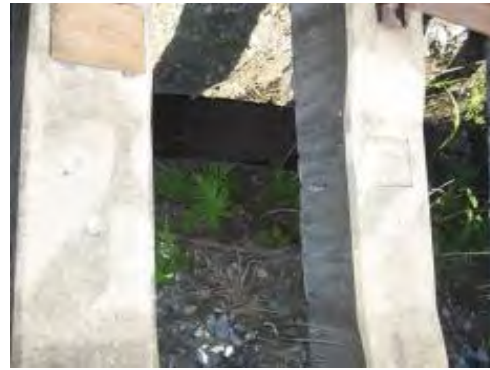
IMÁGENES DEL HUNDIMIENTO DEL TERRAPLÉN FERROVIARIO POR DEFORMACIÓN DE LA SUBRASANTE PK 0307 + 330 EN EL SECTOR COMPRENDIDO ENTRE NARE-GRECIA
