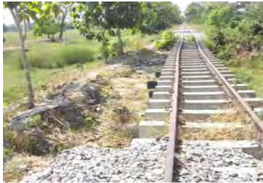
IMÁGENES DE LA SOCAVACIÓN DEL TERRAPLÉN FERROVIARIO PK 0511 + 445 EN EL SECTOR COMPRENDIDO ENTRE BARRANCABERMEJA - SAN RAFAEL
