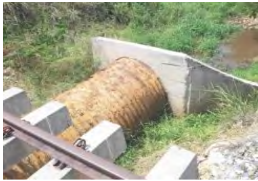
IMÁGENES DEL HUNDIMIENTO DEL TERRAPLÉN FERROVIARIO POR DEFORMACIÓN DE LA SUBRASANTE PK 0514 + 800 EN EL SECTOR COMPRENDIDO ENTRE BARRANCABERMEJA-SAN RAFAEL
