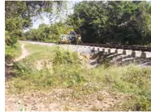
IMÁGENES DEL HUNDIMIENTO DEL TERRAPLÉN FERROVIARIO POR DEFORMACIÓN DE LA SUBRASANTE PK 0678 + 500 EN EL SECTOR COMPRENDIDO ENTRE GAMARRA-CHIRIGUANÁ
