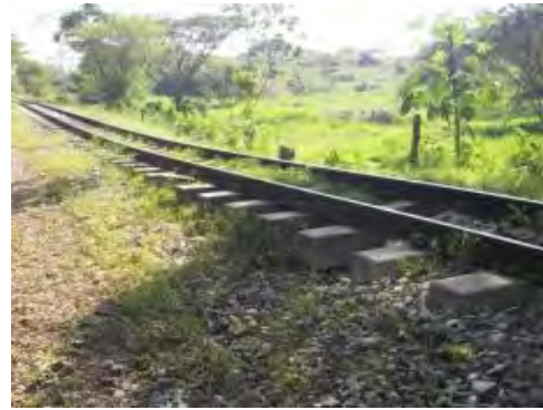
IMÁGENES DEL HUNDIMIENTO DEL TERRAPLÉN FERROVIARIO POR DEFORMACIÓN DE LA SUBRASANTE PK 0299 + 480 EN EL SECTOR COMPRENDIDO ENTRE NARE-GRECIA
