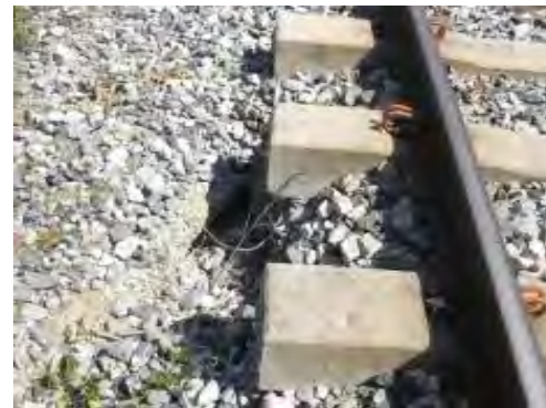
IMÁGENES DEL HUNDIMIENTO DEL TERRAPLÉN FERROVIARIO POR DEFORMACIÓN DE LA SUBRASANTE PK 0312 + 593 EN EL SECTOR COMPRENDIDO ENTRE NARE-GRECIA
