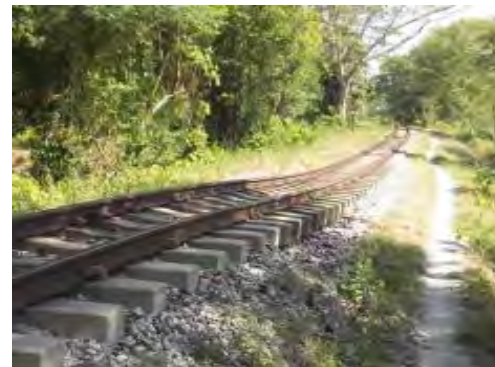
IMÁGENES DEL HUNDIMIENTO DEL TERRAPLÉN FERROVIARIO POR DEFORMACIÓN DE LA SUBRASANTE PK 0301 + 000 EN EL SECTOR COMPRENDIDO ENTRE NARE-GRECIA
