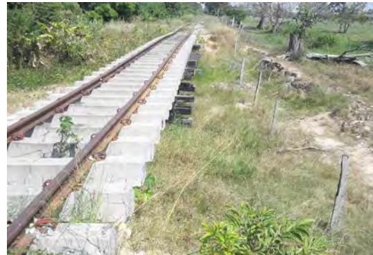
IMÁGENES DE LA SOCAVACIÓN DEL TERRAPLÉN FERROVIARIO PK 0514 + 310 EN EL SECTOR COMPRENDIDO ENTRE BARRANCABERMEJA - SAN RAFAEL
