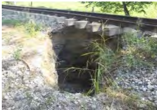
IMÁGENES DEL HUNDIMIENTO DEL TERRAPLÉN FERROVIARIO POR DEFORMACIÓN DE LA SUBRASANTE PK 0300 + 369 EN EL SECTOR COMPRENDIDO ENTRE NARE-GRECIA
