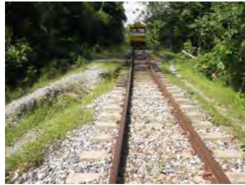
IMÁGENES DEL HUNDIMIENTO DEL TERRAPLÉN FERROVIARIO POR DEFORMACIÓN DE LA SUBRASANTE PK 0285 + 000 EN EL SECTOR COMPRENDIDO ENTRE PUERTO TRIUNFO-NARE
