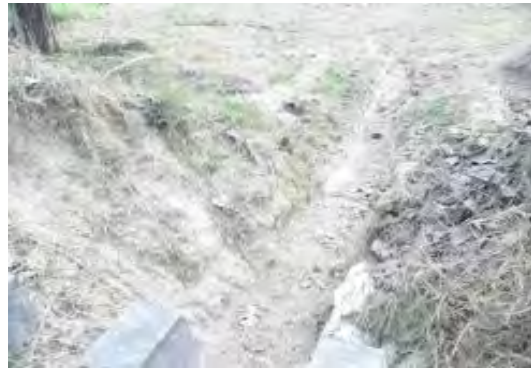
IMÁGENES DEL HUNDIMIENTO DEL TERRAPLÉN FERROVIARIO POR DEFORMACIÓN DE LA SUBRASANTE PK 0511 + 254 EN EL SECTOR COMPRENDIDO ENTRE BARRANCABERMEJA-SAN RAFAEL
