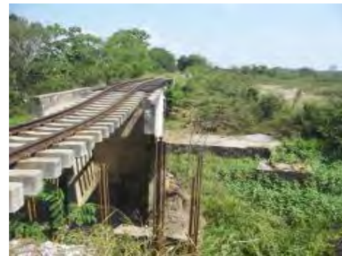
IMÁGENES DE LA SOCAVACIÓN DE ESTRIBOS EN PUENTES PK 0319 + 597 EN EL SECTOR COMPRENDIDO ENTRE NARE-GRECIA
