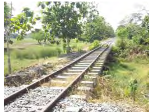
IMÁGENES DE LA SOCAVACIÓN DEL TERRAPLÉN FERROVIARIO PK 0511 + 445 EN EL SECTOR COMPRENDIDO ENTRE BARRANCABERMEJA - SAN RAFAEL
