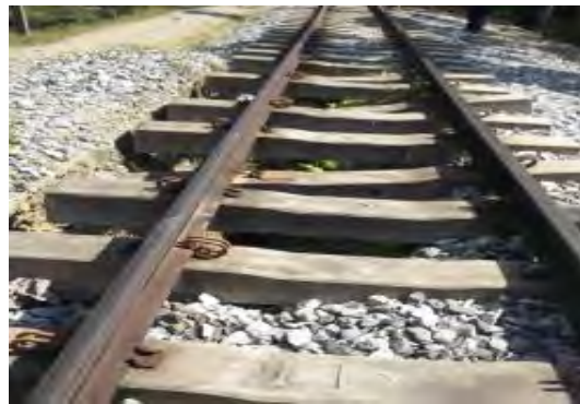
IMÁGENES DEL HUNDIMIENTO DEL TERRAPLÉN FERROVIARIO POR DEFORMACIÓN DE LA SUBRASANTE PK 0307 + 330 EN EL SECTOR COMPRENDIDO ENTRE NARE-GRECIA
