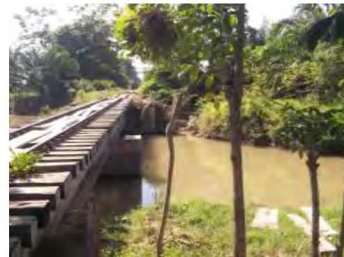
IMÁGENES DEL SOCAVACIÓN DE ESTRIBOS EN PUENTES PK 0678 + 160 EN EL SECTOR COMPRENDIDO ENTRE GAMARRA-CHIRIGUANÁ
