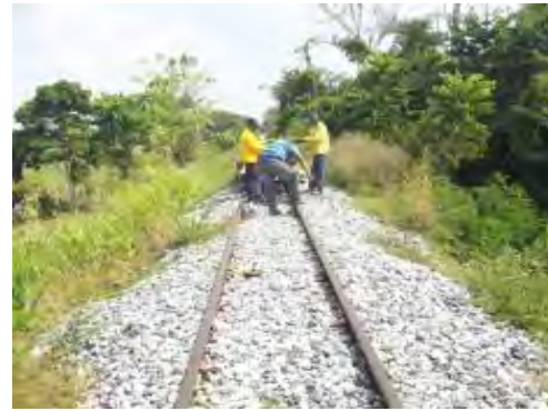
IMÁGENES DEL HUNDIMIENTO DEL TERRAPLÉN FERROVIARIO POR DEFORMACIÓN DE LA SUBRASANTE PK 0506 + 950 EN EL SECTOR COMPRENDIDO ENTRE BARRANCABERMEJA-SAN RAFAEL
