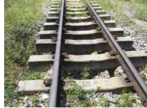
IMÁGENES DEL HUNDIMIENTO DEL TERRAPLÉN FERROVIARIO POR DEFORMACIÓN DE LA SUBRASANTE PK 0323 + 660 EN EL SECTOR COMPRENDIDO ENTRE NARE-GRECIA
