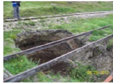
IMÁGENES DEL DESLIZAMIENTO DEL TERRAPLÉN FERROVIARIO A MEDIA LADERA PK 0158 + 100 EN EL SECTOR COMPRENDIDO ENTRE TIERRA NEGRA-SAMACÁ
