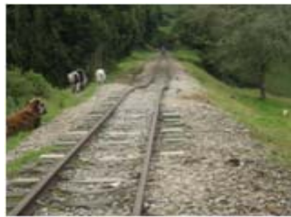
IMÁGENES DEL DESPLAZAMIENTO DEL TERRAPLÉN FERROVIARIO A MEDIA LADERA PK 0139 + 100 EN EL SECTOR COMPRENDIDO ENTRE VENTAQUEMADA-TIERRA NEGRA
