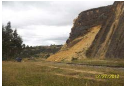
IMÁGENES DEL DESPLIZAMIENTO DE TALUD CON TERRAPLÉN FERROVIARIO A PIE DE LADERA PK 0123 + 200 EN EL SECTOR COMPRENDIDO ENTRE ALBARRACIN-VENTAQUEMADA
