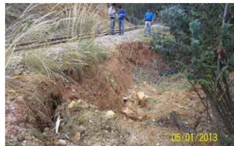
IMÁGENES DEL DESPLAZAMIENTO DEL TERRAPLÉN FERROVIARIO A MEDIA LADERA PK 0188 + 800 EN EL SECTOR COMPRENDIDO ENTRE TUNJA-TUTA
