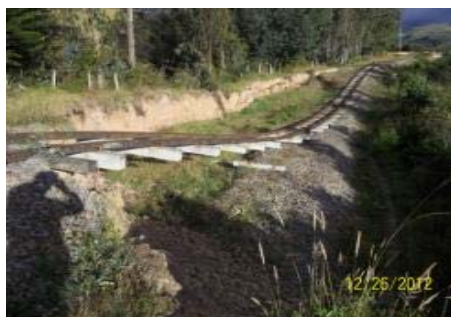
IMÁGENES DEL DESLIZAMIENTO DEL TERRAPLÉN FERROVIARIO A MEDIA LADERA PK 0117 + 750 EN EL SECTOR COMPRENDIDO ENTRE VILLA PINZÓN-ALBARRACÍN
