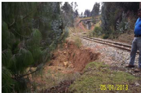
IMÁGENES DEL DESPLAZAMIENTO DEL TERRAPLÉN FERROVIARIO A MEDIA LADERA PK 0188 + 800 EN EL SECTOR COMPRENDIDO ENTRE TUNJA-TUTA
