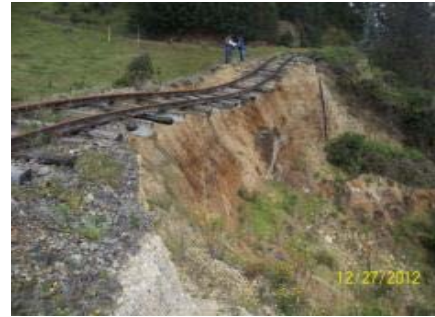
IMÁGENES DEL DESPLAZAMIENTO DE TALUD CON TERRAPLÉN FERROVIARIO A PIE DE LADERA PK 0126 + 200 EN EL SECTOR COMPRENDIDO ENTRE ALBARRACIN-VENTAQUEMADA
