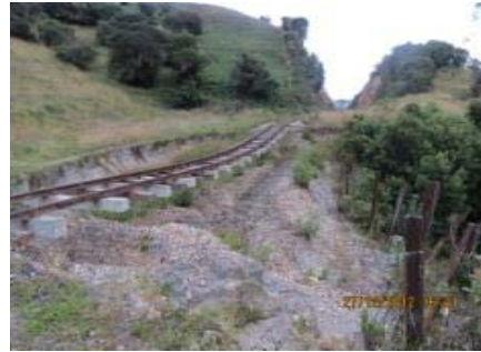
IMÁGENES DEL DESPLAZAMIENTO DE TALUD CON TERRAPLÉN FERROVIARIO A PIE DE LADERA PK 0130 + 000 EN EL SECTOR COMPRENDIDO ENTRE ALBARRACÍN-VENTAQUEMADA
