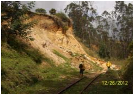
IMÁGENES DEL DESLIZAMIENTO DE TALUD CON TERRAPLÉN FERROVIARIO A PIE DE LADERA PK 079 + 250 EN EL SECTOR COMPRENDIDO ENTRE SUESCA-SANTA ROSA
