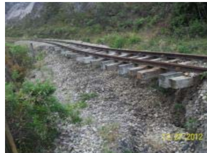
IMÁGENES DEL DESPLAZAMIENTO DE TALUD CON TERRAPLÉN FERROVIARIO A PIE DE LADERA PK 0129 + 900 EN EL SECTOR COMPRENDIDO ENTRE ALBARRACÍN-VENTAQUEMADA
