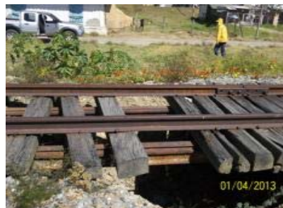
IMÁGENES DEL HUNDIMIENTO DEL TERRAPLÉN FERROVIARIO POR DEFORMACIÓN DE LA SUBRASANTE PK 0224 + 900 EN EL SECTOR COMPRENDIDO ENTRE TUTA-PAIPA
