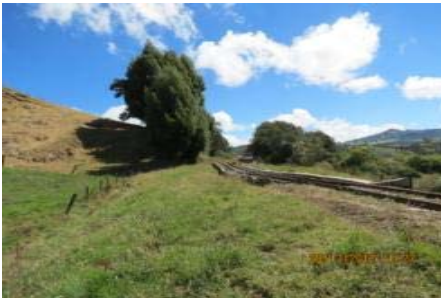
IMÁGENES DEL HUNDIMIENTO DEL TERRAPLÉN FERROVIARIO POR DEFORMACIÓN DE LA SUBRASANTE PK 0142 + 700 EN EL SECTOR COMPRENDIDO ENTRE VENTAQUEMADA-TIERRA NEGRA
