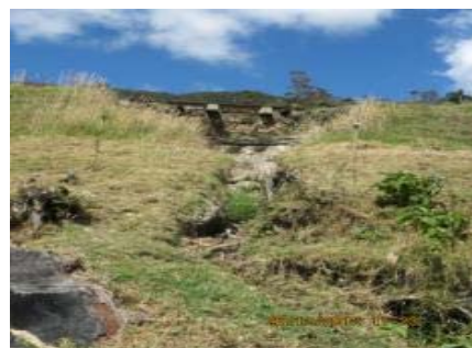
IMÁGENES DEL DESLIZAMIENTO DEL TERRAPLEN FERROVIARIO A MEDIA LADERA PK 0140 + 435 EN EL SECTOR COMPRENDIDO ENTRE VENTAQUEMADA-TIERRA NEGRA
