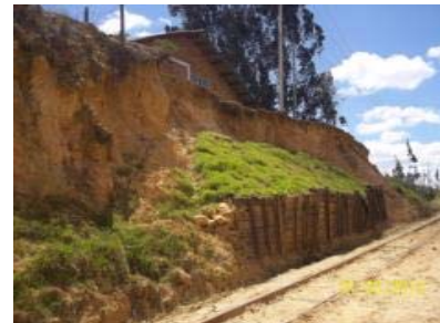
IMÁGENES DEL DESPLAZAMIENTO DE TALUDES CON PASO DE FERROVÍA EN CORTE DE LADERA PK 0188 + 150 EN EL SECTOR COMPRENDIDO ENTRE TUNJA-TUTA
