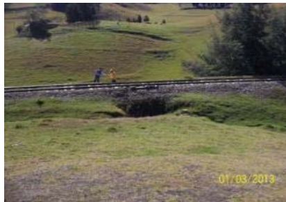
IMÁGENES DEL DESLIZAMIENTO DEL TERRAPLÉN FERROVIARIO A MEDIA LADERA PK 0175 + 865 EN EL SECTOR COMPRENDIDO ENTRE SAMACÁ-TUNJA
