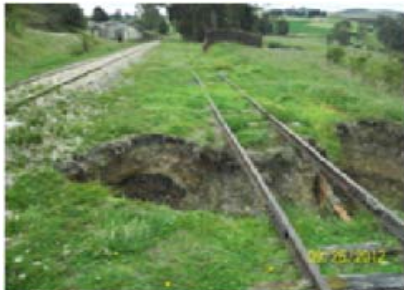
IMÁGENES DEL DESLIZAMIENTO DEL TERRAPLÉN FERROVIARIO A MEDIA LADERA PK 0158 + 100 EN EL SECTOR COMPRENDIDO ENTRE TIERRA NEGRA-SAMACÁ
