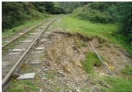
IMÁGENES DEL DESLIZAMIENTO DEL TERRAPLÉN FERROVIARIO A MEDIA LADERA PK 0137 + 900 EN EL SECTOR COMPRENDIDO ENTRE VENTAQUEMADA-TIERRA NEGRA
