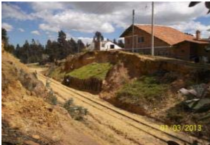
IMÁGENES DEL DESPLAZAMIENTO DE TALUDES CON PASO DE FERROVÍA EN CORTE DE LADERA PK 0188 + 150 EN EL SECTOR COMPRENDIDO ENTRE TUNJA-TUTA
