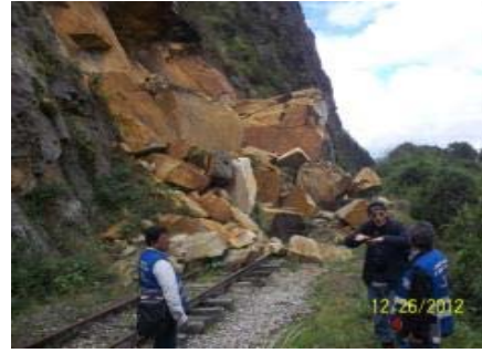
IMÁGENES DEL DESLIZAMIENTO DE TALUD CON TERRAPLÉN FERROVIARIO A PIE DE LADERA PK 076 + 670 EN EL SECTOR COMPRENDIDO ENTRE SUESCA-SANTA ROSA
