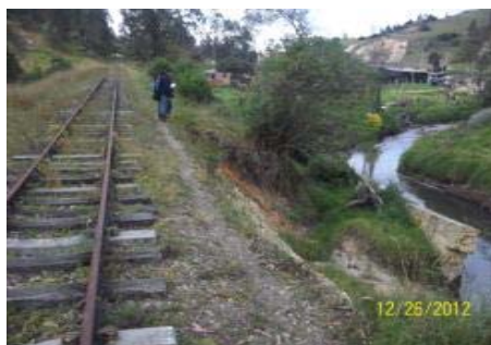
IMÁGENES DEL DESPLAZAMIENTO LATERAL DEL CAUCE DEL RIO PK 0103 + 470 EN EL SECTOR COMPRENDIDO ENTRE CHOCONTA-VILLA PINZÓN
