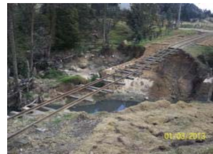
IMÁGENES DEL SOCAVACIÓN DE TERRAPLÉN FERROVIARIO EN CAUCE DE RIO PK 0188 + 353 EN EL SECTOR COMPRENDIDO ENTRE TUNJA-TUTA
