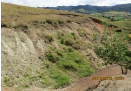
IMÁGENES DEL DESLIZAMIENTO DE TALUDES CON PASO DE FERROVÍA EN CORTE DE LADERA PK 0112 + 500 EN EL SECTOR COMPRENDIDO ENTRE VILLA PINZÓN-ALBARRACÍN
