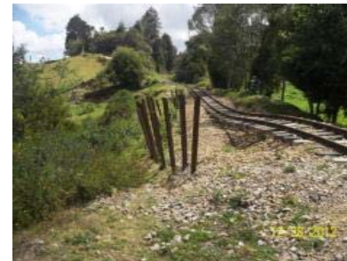
IMÁGENES DEL DESLIZAMIENTO DEL TERRAPLÉN FERROVIARIO A MEDIA LADERA PK 0153 + 680 EN EL SECTOR COMPRENDIDO ENTRE TIERRA NEGRA-SAMACÁ
