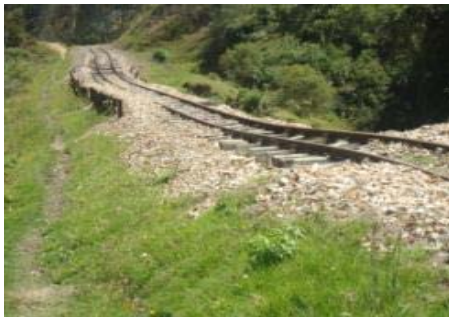
IMÁGENES DEL DESPLIZAMIENTO DEL TERRAPLÉN FERROVIARIO A MEDIA LADERA PK 0127 + 280 EN EL SECTOR COMPRENDIDO ENTRE ALBARRACÍN-VENTAQUEMADA
