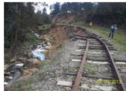
IMÁGENES DEL DESPLAZAMIENTO LATERAL DEL CAUCE DEL RIO PK 0188 + 600 EN EL SECTOR COMPRENDIDO ENTRE TUNJA-TUTA
