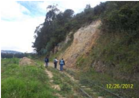
IMÁGENES DEL DESLIZAMIENTO DE TALUD CON TERRAPLÉN FERROVIARIO A PIE DE LADERA PK 065 + 100 EN EL SECTOR COMPRENDIDO ENTRE GACHANCIPA-SUESCA
