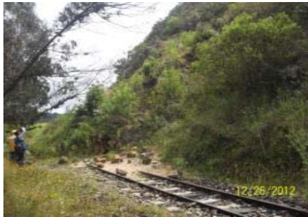
IMÁGENES DEL DESLIZAMIENTO DE TALUD CON TERRAPLÉN FERROVIARIO A PIE DE LADERA PK 077 + 520 EN EL SECTOR COMPRENDIDO ENTRE SUESCA-SANTA ROSA
