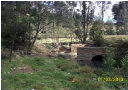
IMÁGENES DEL SOCAVACIÓN DE TERRAPLÉN FERROVIARIO EN CAUCE DE RIO PK 0188 + 353 EN EL SECTOR COMPRENDIDO ENTRE TUNJA-TUTA
