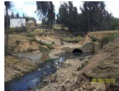
IMÁGENES DEL SOCAVACIÓN DE TERRAPLÉN FERROVIARIO EN CAUCE DE RIO PK 0188 + 250 EN EL SECTOR COMPRENDIDO ENTRE TUNJA-TUTA
