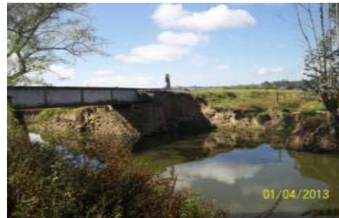
IMÁGENES DEL SOCAVACIÓN DE ESTRIBOS EN PUENTES PK 0209 + 300 EN EL SECTOR COMPRENDIDO ENTRE TUTA-PAIPA
