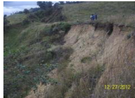
IMÁGENES DEL DESPLIZAMIENTO DE TALUD CON TERRAPLÉN FERROVIARIO A PIE DE LADERA PK 0128 + 400 EN EL SECTOR COMPRENDIDO ENTRE ALBARRACIN-VENTAQUEMADA
