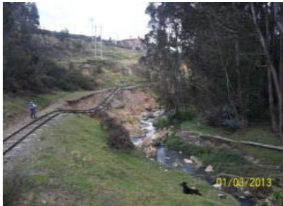
IMÁGENES DEL DESPLAZAMIENTO LATERAL DEL CAUCE DEL RIO PK 0188 + 600 EN EL SECTOR COMPRENDIDO ENTRE TUNJA-TUTA
