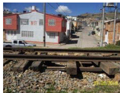
IMÁGENES DEL HUNDIMIENTO DEL TERRAPLÉN FERROVIARIO POR DEFORMACIÓN DE LA SUBRASANTE PK 0179 + 305 EN EL SECTOR COMPRENDIDO ENTRE SAMACÁ-TUNJA
