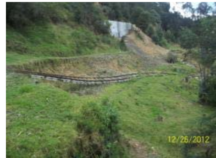
IMÁGENES DEL DESLIZAMIENTO DEL TERRAPLÉN FERROVIARIO A MEDIA LADERA PK 079 + 800 EN EL SECTOR COMPRENDIDO ENTRE SUESCA-SANTA ROSA
