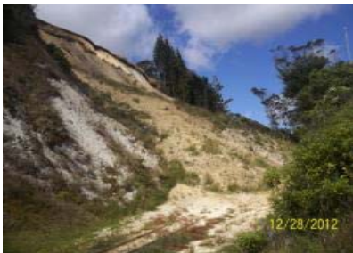
IMÁGENES DEL DESLIZAMIENTO DE TALUDES CON PASO DE FERROVÍA EN CORTE DE LADERA PK 0164 + 300 EN EL SECTOR COMPRENDIDO ENTRE SAMACÁ-TUNJA
