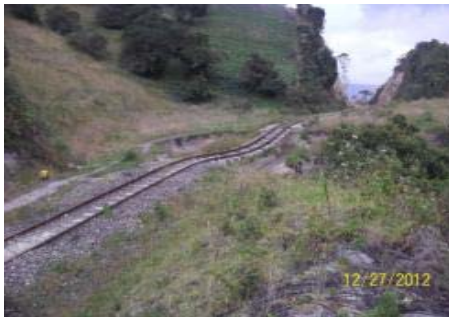
IMÁGENES DEL DESPLAZAMIENTO DE TALUD CON TERRAPLÉN FERROVIARIO A PIE DE LADERA PK 0130 + 000 EN EL SECTOR COMPRENDIDO ENTRE ALBARRACÍN-VENTAQUEMADA
