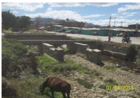
IMÁGENES DEL SOCAVACIÓN DE ESTRIBOS EN PUENTES PK 0255 + 200 EN EL SECTOR COMPRENDIDO ENTRE DUITAMA-BELENICITO
