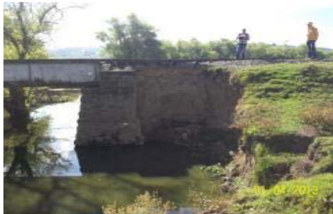
IMÁGENES DEL SOCAVACIÓN DE ESTRIBOS EN PUENTES PK 0209 + 300 EN EL SECTOR COMPRENDIDO ENTRE TUTA-PAIPA
