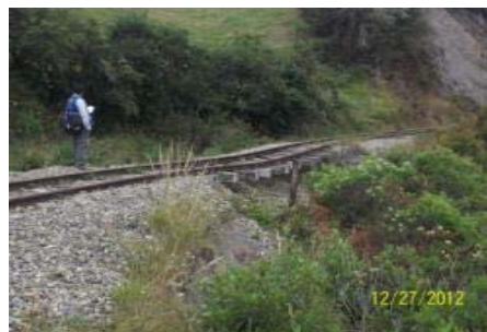
IMÁGENES DEL DESPLAZAMIENTO DE TALUD CON TERRAPLÉN FERROVIARIO A PIE DE LADERA PK 0129 + 900 EN EL SECTOR COMPRENDIDO ENTRE ALBARRACÍN-VENTAQUEMADA
