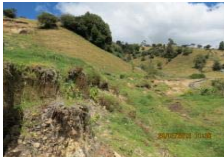
IMÁGENES DEL DESPLAZAMIENTO DEL TERRAPLÉN FERROVIARIO A MEDIA LADERA PK 0140 + 280 EN EL SECTOR COMPRENDIDO ENTRE VENTAQUEMADA-TIERRA NEGRA
