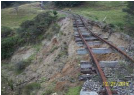
IMÁGENES DEL DESPLAZAMIENTO DE TALUD CON TERRAPLÉN FERROVIARIO A PIE DE LADERA PK 0126 + 200 EN EL SECTOR COMPRENDIDO ENTRE ALBARRACIN-VENTAQUEMADA
