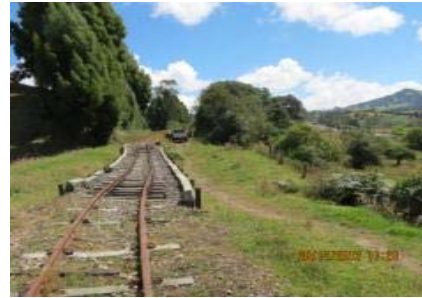
IMÁGENES DEL HUNDIMIENTO DEL TERRAPLÉN FERROVIARIO POR DEFORMACIÓN DE LA SUBRASANTE PK 0142 + 700 EN EL SECTOR COMPRENDIDO ENTRE VENTAQUEMADA-TIERRA NEGRA
