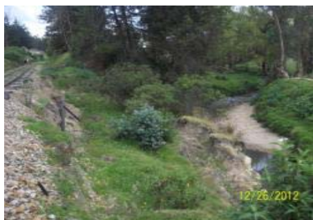
IMÁGENES DEL DESPLAZAMIENTO LATERAL DEL CAUCE DEL RIO PK 0103 + 770 EN EL SECTOR COMPRENDIDO ENTRE CHOCONTA-VILLA PINZÓN
