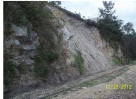
IMÁGENES DEL DESLIZAMIENTO DE TALUD CON TERRAPLEN FERROVIARIO A PIE DE LADERA PK 066 + 100 EN EL SECTOR COMPRENDIDO ENTRE GACHANCIPA-SUESCA
