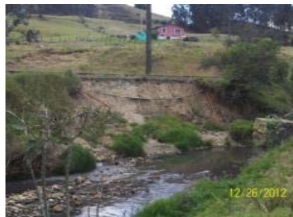
IMÁGENES DEL DESPLAZAMIENTO LATERAL DEL CAUCE DEL RIO PK 0103 + 470 EN EL SECTOR COMPRENDIDO ENTRE CHOCONTA-VILLA PINZÓN
