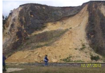
IMÁGENES DEL DESPLIZAMIENTO DE TALUD CON TERRAPLÉN FERROVIARIO A PIE DE LADERA PK 0123 + 200 EN EL SECTOR COMPRENDIDO ENTRE ALBARRACIN-VENTAQUEMADA
