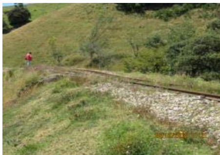
IMÁGENES DEL DESLIZAMIENTO DEL TERRAPLEN FERROVIARIO A MEDIA LADERA PK 0140 + 435 EN EL SECTOR COMPRENDIDO ENTRE VENTAQUEMADA-TIERRA NEGRA
