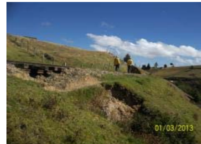
IMÁGENES DEL DESLIZAMIENTO DEL TERRAPLÉN FERROVIARIO A MEDIA LADERA PK 0175 + 865 EN EL SECTOR COMPRENDIDO ENTRE SAMACÁ-TUNJA
