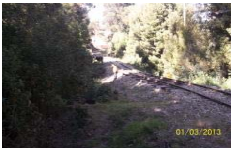
IMÁGENES DEL HUNDIMIENTO DEL TERRAPLÉN FERROVIARIO POR DEFORMACIÓN DE LA SUBRASANTE PK 0189 + 800 EN EL SECTOR COMPRENDIDO ENTRE TUNJA-TUTA
