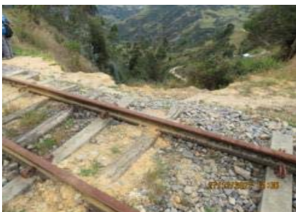
IMÁGENES DEL DESLIZAMIENTO DEL TERRAPLÉN FERROVIARIO A MEDIA LADERA PK 0123 + 000 EN EL SECTOR COMPRENDIDO ENTRE ALBARRACÍN-VENTA QUEMADA
