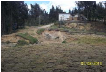
IMÁGENES DEL SOCAVACIÓN DE TERRAPLÉN FERROVIARIO EN CAUCE DE RIO PK 0188 + 250 EN EL SECTOR COMPRENDIDO ENTRE TUNJA-TUTA
