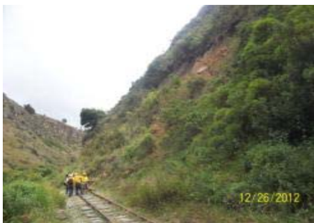
IMÁGENES DEL DESLIZAMIENTO DE TALUD CON TERRAPLÉN FERROVIARIO A PIE DE LADERA PK 076 + 800 EN EL SECTOR COMPRENDIDO ENTRE SUESCA-SANTA ROSA
