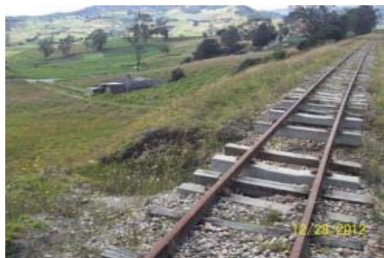
IMÁGENES DEL DESLIZAMIENTO DEL TERRAPLÉN FERROVIARIO A MEDIA LADERA PK 0161 + 700 EN EL SECTOR COMPRENDIDO ENTRE SAMACÁ-TUNJA
