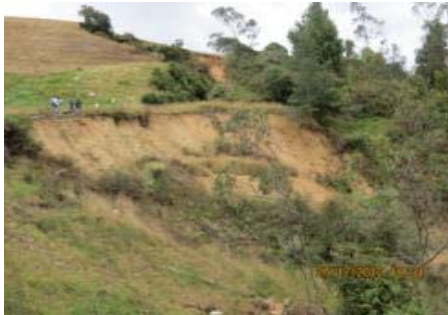
IMÁGENES DEL DESPLIZAMIENTO DE TALUD CON TERRAPLÉN FERROVIARIO A PIE DE LADERA PK 0128 + 400 EN EL SECTOR COMPRENDIDO ENTRE ALBARRACIN-VENTAQUEMADA
