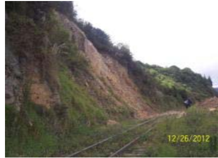
IMÁGENES DEL DESLIZAMIENTO DE TALUD CON TERRAPLÉN FERROVIARIO A PIE DE LADERA PK 065 + 100 EN EL SECTOR COMPRENDIDO ENTRE GACHANCIPA-SUESCA
