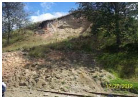
IMÁGENES DEL DESLIZAMIENTO DE TALUD CON TERRAPLÉN FERROVIARIO A PIE DE LADERA PK 0112 + 720 EN EL SECTOR COMPRENDIDO ENTRE VILLA PINZÓN-ALBARRACÍN
