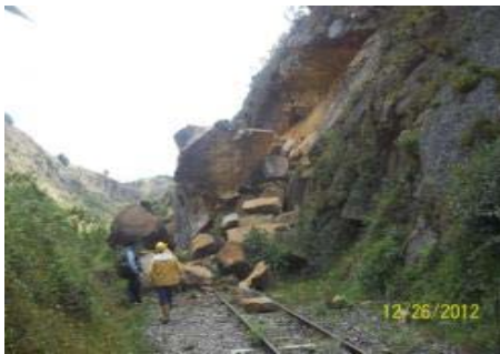
IMÁGENES DEL DESLIZAMIENTO DE TALUD CON TERRAPLÉN FERROVIARIO A PIE DE LADERA PK 076 + 670 EN EL SECTOR COMPRENDIDO ENTRE SUESCA-SANTA ROSA
