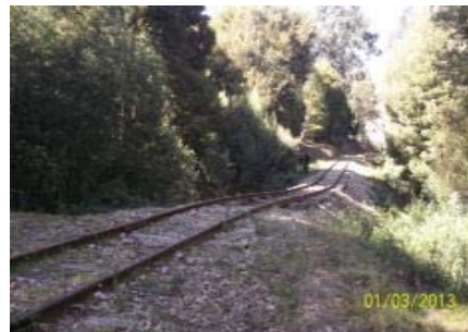
IMÁGENES DEL HUNDIMIENTO DEL TERRAPLÉN FERROVIARIO POR DEFORMACIÓN DE LA SUBRASANTE PK 0189 + 800 EN EL SECTOR COMPRENDIDO ENTRE TUNJA-TUTA
