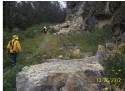
IMÁGENES DEL DESLIZAMIENTO DE TALUD CON TERRAPLÉN FERROVIARIO A PIE DE LADERA PK 077 + 900 EN EL SECTOR COMPRENDIDO ENTRE SUESCA-SANTA ROSA
