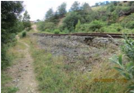
IMÁGENES DEL DESPLIZAMIENTO DEL TERRAPLÉN FERROVIARIO A MEDIA LADERA PK 0119 + 250 EN EL SECTOR COMPRENDIDO ENTRE VILLA PINZÓN-ALBARRACÍN
