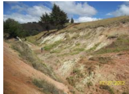
IMÁGENES DEL DESLIZAMIENTO DE TALUDES CON PASO DE FERROVÍA EN CORTE DE LADERA PK 0112 + 500 EN EL SECTOR COMPRENDIDO ENTRE VILLA PINZÓN-ALBARRACÍN
