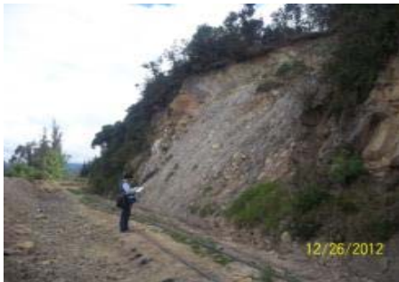
IMÁGENES DEL DESLIZAMIENTO DE TALUD CON TERRAPLEN FERROVIARIO A PIE DE LADERA PK 066 + 100 EN EL SECTOR COMPRENDIDO ENTRE GACHANCIPA-SUESCA
