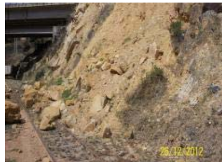
IMÁGENES DEL DESLIZAMIENTO DE TALUDES CON PASO DE FERROVÍA EN CORTE DE LADERA PK 0188 + 650 EN EL SECTOR COMPRENDIDO ENTRE TUNJA - TUTA
