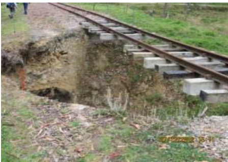
IMÁGENES DEL DESPLAZAMIENTO DE TALUD CON TERRAPLÉN FERROVIARIO A PIE DE LADERA PK 0126 + 700 EN EL SECTOR COMPRENDIDO ENTRE ALBARRACIN-VENTAQUEMADA
