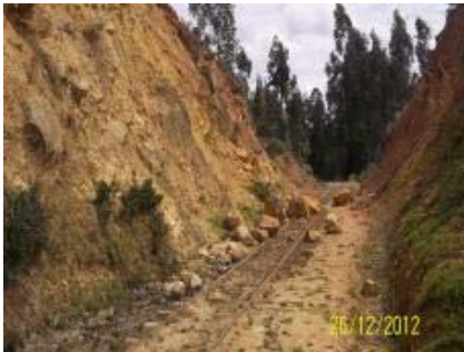
IMÁGENES DEL DESLIZAMIENTO DE TALUDES CON PASO DE FERROVÍA EN CORTE DE LADERA PK 0188 + 650 EN EL SECTOR COMPRENDIDO ENTRE TUNJA - TUTA
