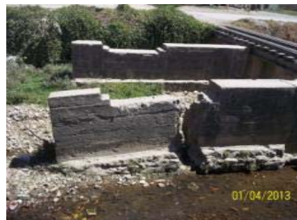
IMÁGENES DEL SOCAVACIÓN DE ESTRIBOS EN PUENTES PK 0255 + 200 EN EL SECTOR COMPRENDIDO ENTRE DUITAMA-BELENICITO
