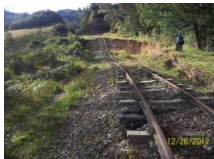
IMÁGENES DEL DESLIZAMIENTO DEL TERRAPLÉN FERROVIARIO A MEDIA LADERA PK 0117 + 750 EN EL SECTOR COMPRENDIDO ENTRE VILLA PINZÓN-ALBARRACÍN
