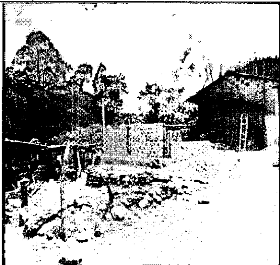
Foto 26 Vivienda en construcción localizada en zona de alto riesgo, ya que el viaducto planteado en el diseño de la alternativa 2 quedaría encima de esta vivienda. Con medidas de manejo se puede manejar este impacto en el centro poblado de San Juan.
