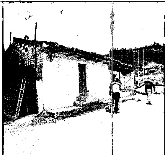
Foto 27 Una de las viviendas que quedarían en zona de alto riesgo, ya que el viaducto planteado en el diseño de la alternativa 2 quedaría encima de estas viviendas. Con medidas de manejo se puede manejar este impacto en el centro poblado de San Juan.
