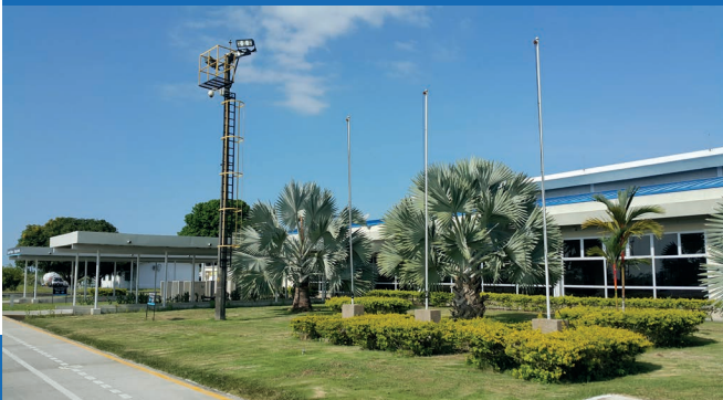
Aeropuerto de Carepa
