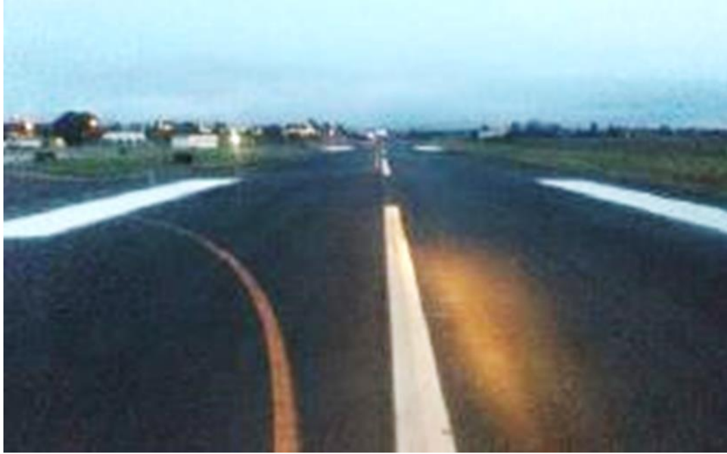
Ampliación de Pista y Plataforma – El Caraño
