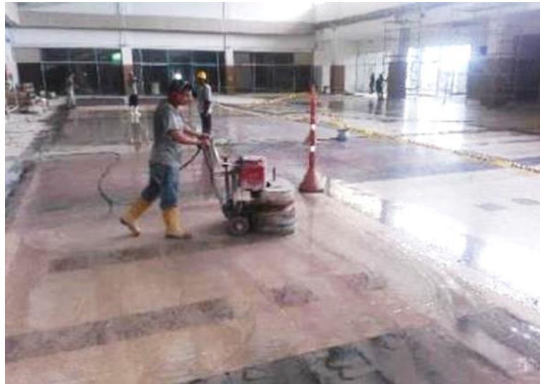
Ampliación de Terminal de Servicios – El Caraño
