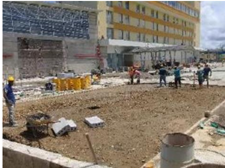
Ampliación de Terminal de Servicios – El Caraño
