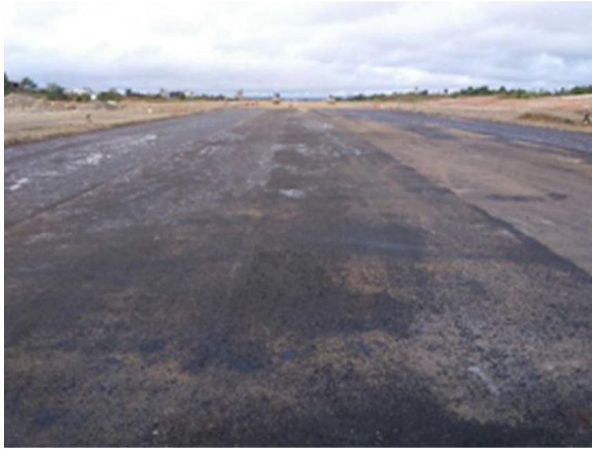
Ampliación de Pista y Plataforma – El Caraño
