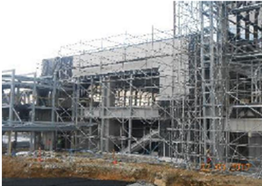
Fachada edificio muelle internacional instalación equitone – José María Córdova
