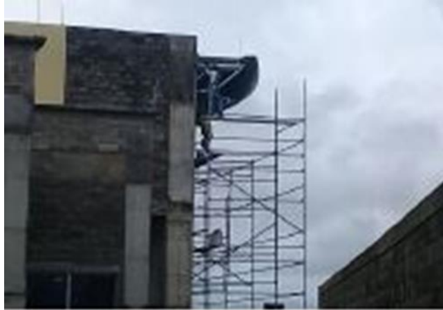
Ampliación de Terminal de Servicios – El Caraño
