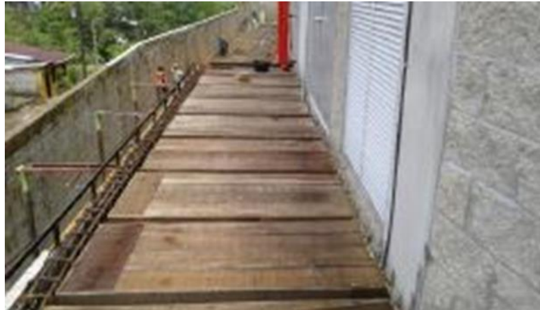
Ampliación de Terminal de Servicios – El Caraño
