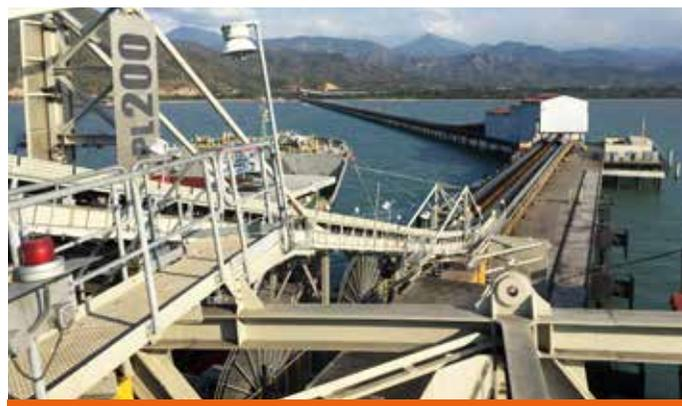
portadoras encapsuladas, un muelle con dos posiciones de atraque y cargador de barcos con una capacidad nominal de 8.000 T/H y un dragado de profundización de 20,3 metros.
