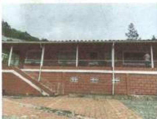
C1: CONSTRUCCIÓN 1 - FACHADA
