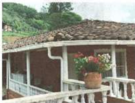
C1: CONSTRUCCIÓN 1 - CUBIERTA
