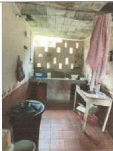
C1: CONSTRUCCIÓN 1 – PATIO DE ROPAS
