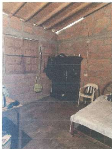
C1: CONSTRUCCIÓN 1 – HABITACIÓN 2
