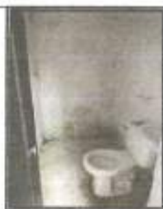
Descripción: Vista construcción 2.
