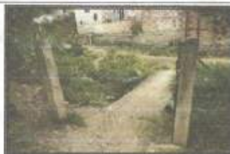
Descripción: Vista puente.
