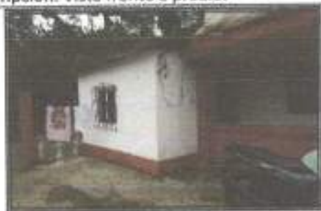
Descripción: Vista construcción 1.
