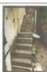
Descripción: Vista escaleras.
