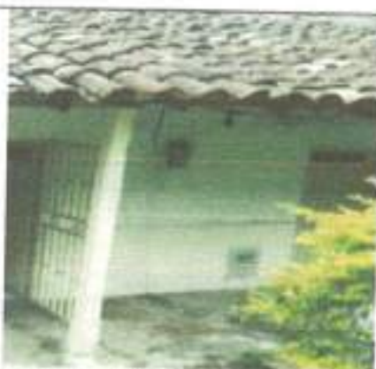
CONSTRUCCIÓN ANEXA 4. CUBIERTA
