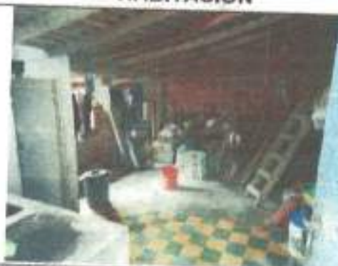
CONSTRUCCIÓN PRINCIPAL: CUARTO DE ROPAS
