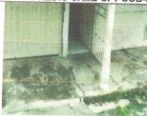
CONSTRUCCIÓN ANEXA 3. ZONA DURA
