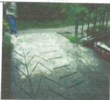
CONSTRUCCIÓN ANEXA 5. RAMPA VEHICULAR
