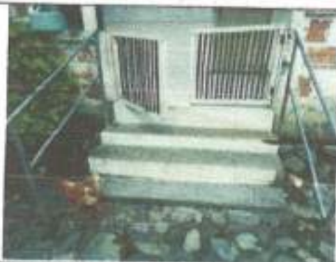
CONSTRUCCIÓN ANEXA 2. ESCALERA
