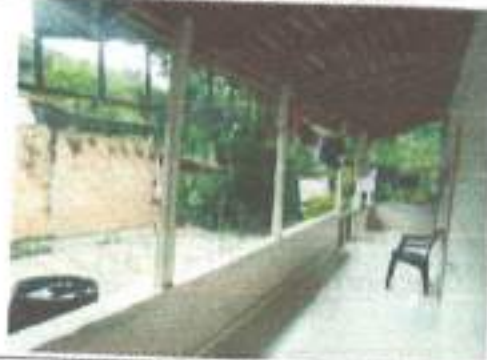
CONSTRUCCIÓN ANEXA 1. CORREDOR CUBIERTO
