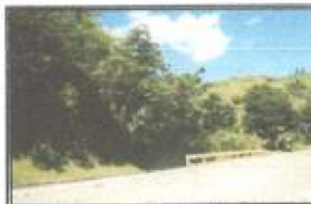
Descripción: Vista sobre la Vía.
