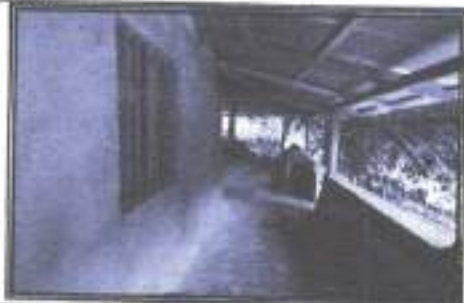
Descripción: Vista corredor cubierto.
