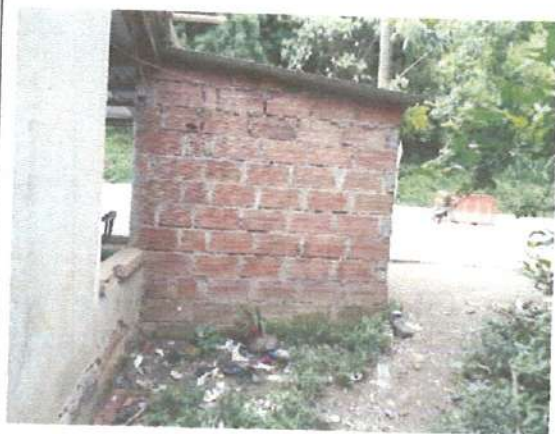
C1: CONSTRUCCION 1- FACHADA
