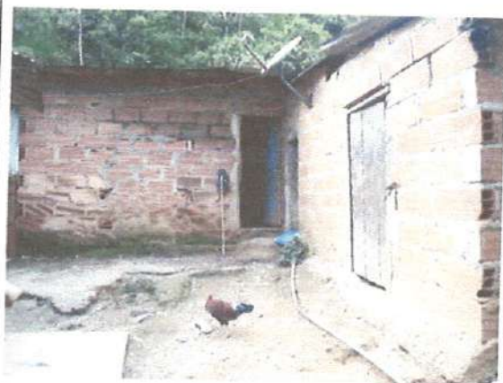
C2: CONSTRUCCION 2 – FACHADA
