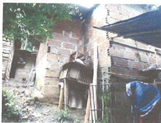
C4: CONSTRUCCION 4- FACHADA
