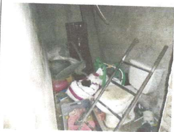
C3: CONSTRUCCION 3- BAÑO
