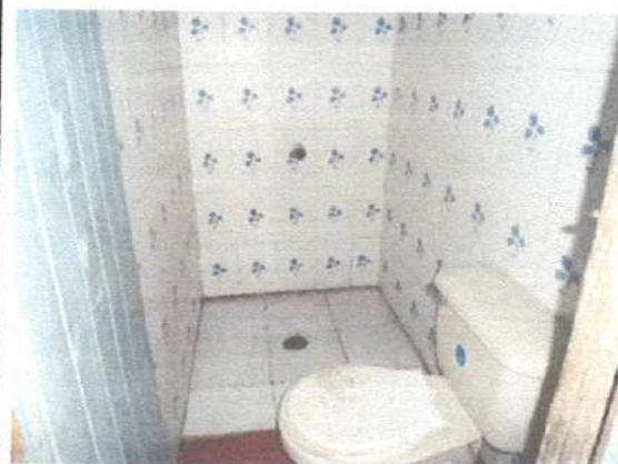
C4: CONSTRUCCION 4- BAÑO
