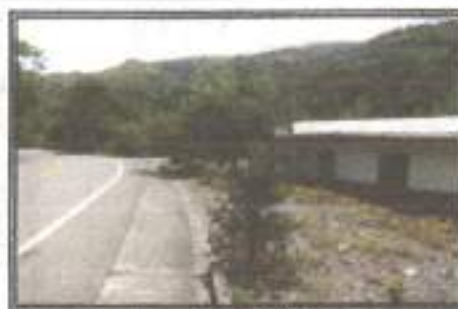
Descripción: Vista sobre la Vía.
