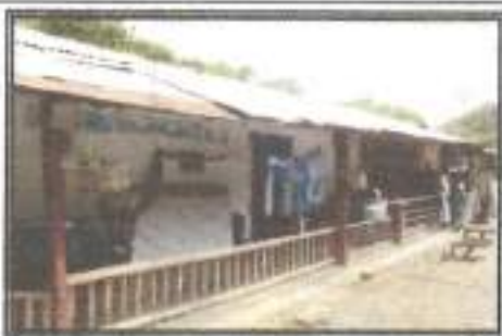
Descripción: Vista Corredor Cubierto 1.
