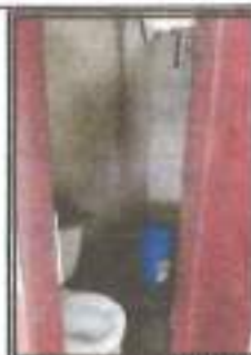
Descripción: Vista Construcción 1 – Baño.
