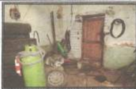
Descripción: Vista Construcción 1 – Habitación.
