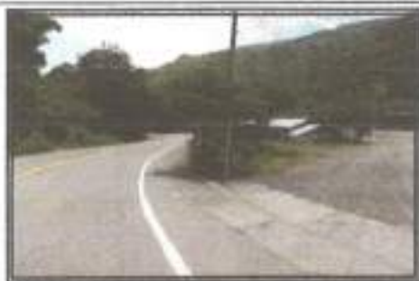
Descripción: Vista sobre la Vía.
