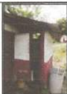
Descripción: Vista Construcción 1 – Baño.
