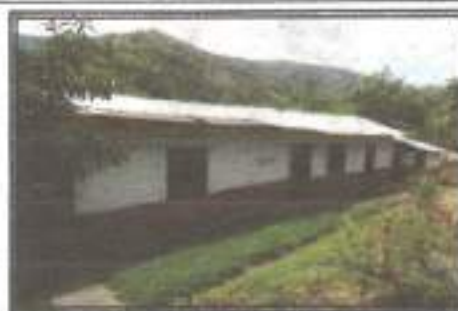
Descripción: Vista Construcción 1.
