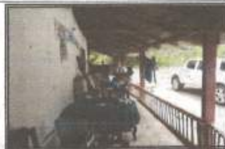
Descripción: Vista Corredor Cubierto 1.
