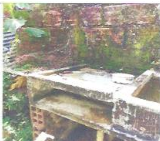
Vista tanque y lavadero (CA3, CA4)
