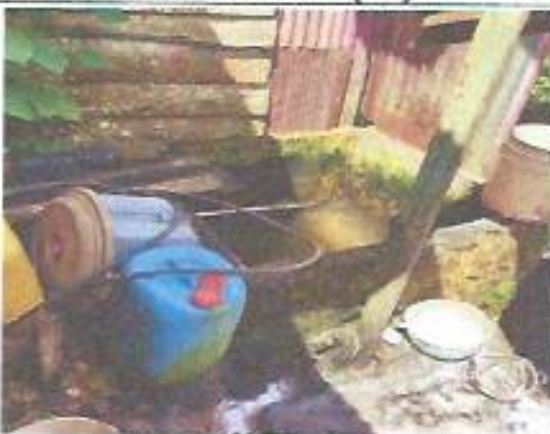
Vista Tanque de agua (CA8)
