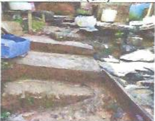
Vista escalera (CA9)
