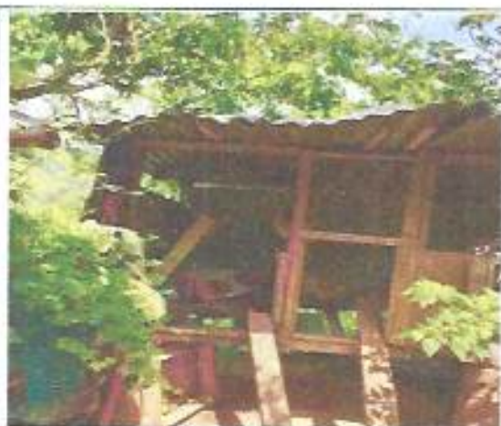
Vista de gallinero (CA4)
