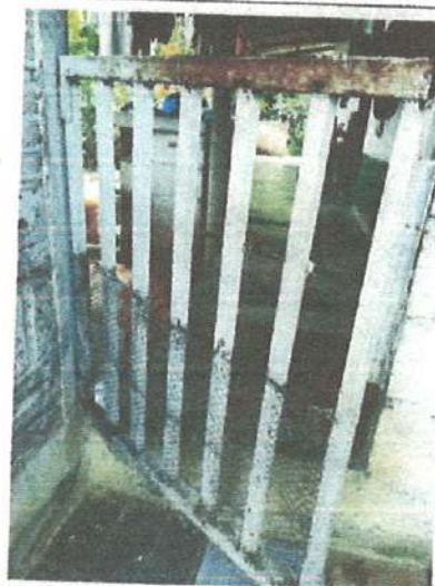
CA8: CORREDOR CUBIERTO- PUERTAS
