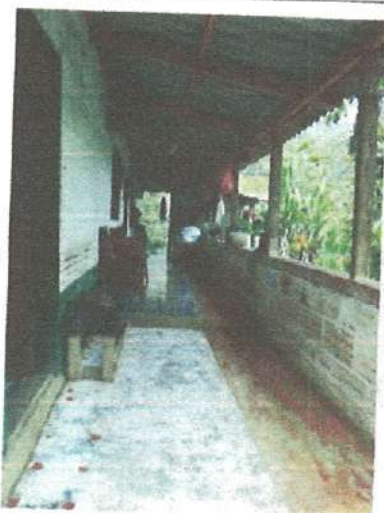
CA8: CORREDOR CUBIERTO
