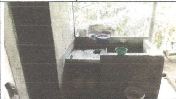
C2: CONSTRUCCIÓN 2-BAÑO FACHADA
