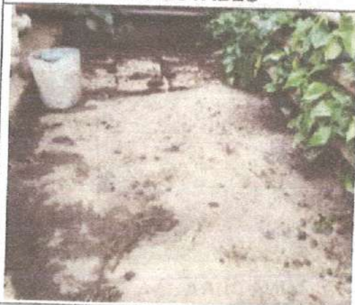
CA10: POZO SÉPTICO
