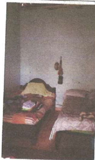
C1: CONSTRUCCIÓN 1 – ALCOBA 4
