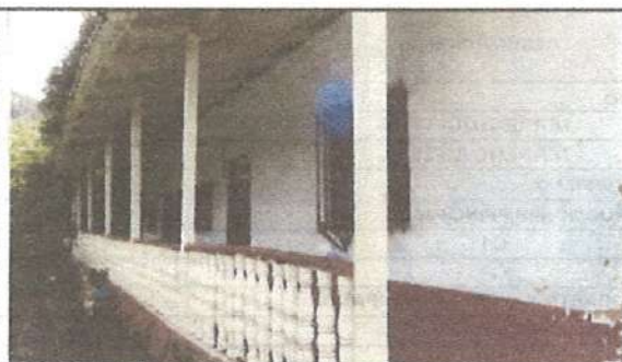
C1: CONSTRUCCIÓN 1-FACHADA LATERAL
