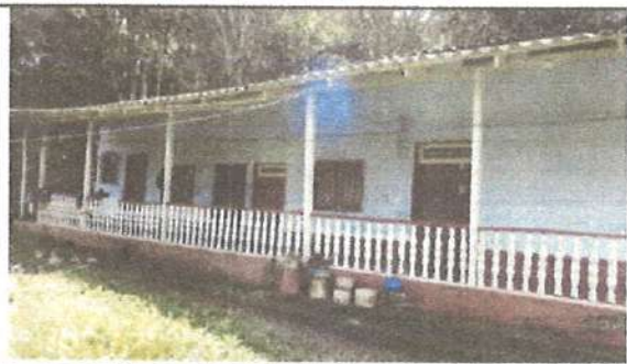
C1: CONSTRUCCIÓN 1-FACHADA
