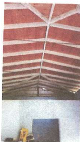
C1: CONSTRUCCIÓN 1 – CUBIERTA
