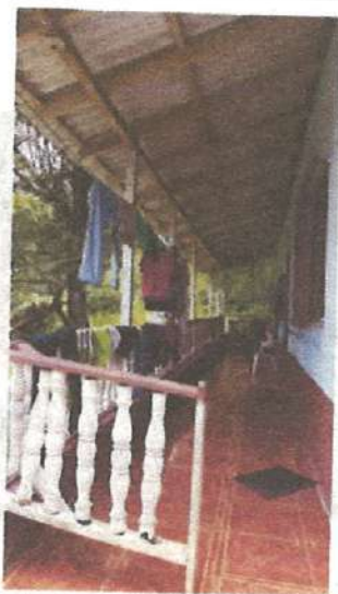
CA1: CORREDOR CUBIERTO
