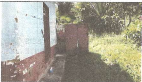
C1: CONSTRUCCIÓN 1-FACHADA LATERAL
