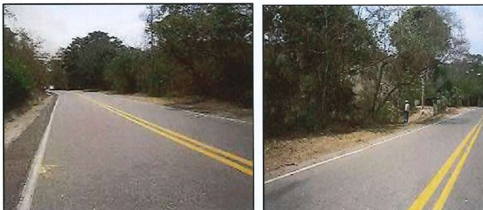
Vista general vía de acceso – frente predio
