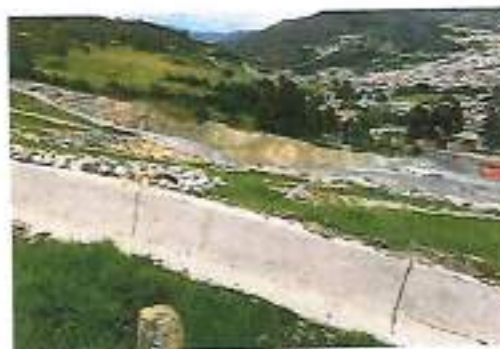
Registro fotográfico área intervenida.
