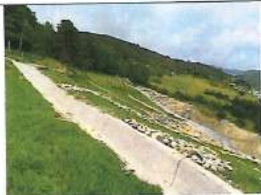
Registro fotográfico área intervenida.
