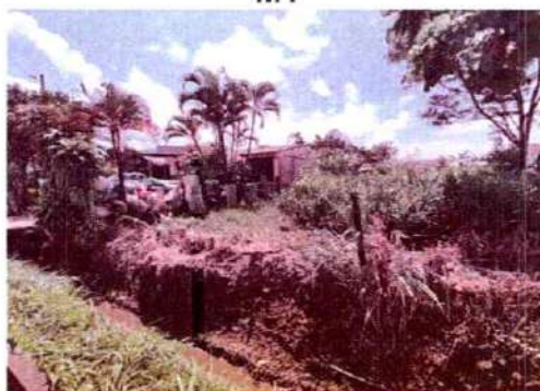
CONSTRUCCIÓN ANEXA M1
