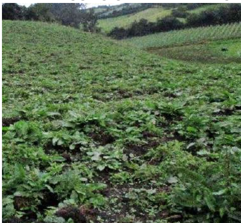
A2: ADECUACIÓN DE TERRENO
