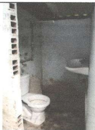
CONSTRUCCIÓN C1 BAÑO 1
