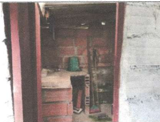
CONSTRUCCIÓN C1 COCINA 2
