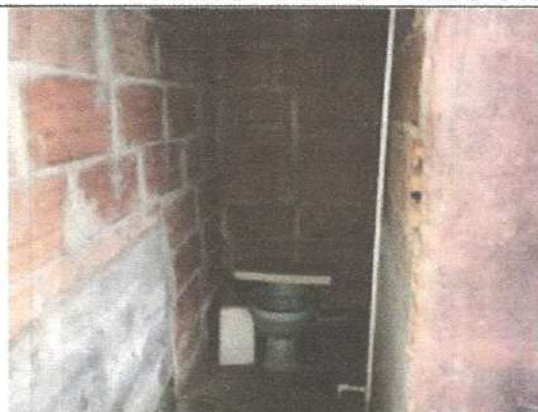
CONSTRUCCIÓN C1 BAÑO 2
