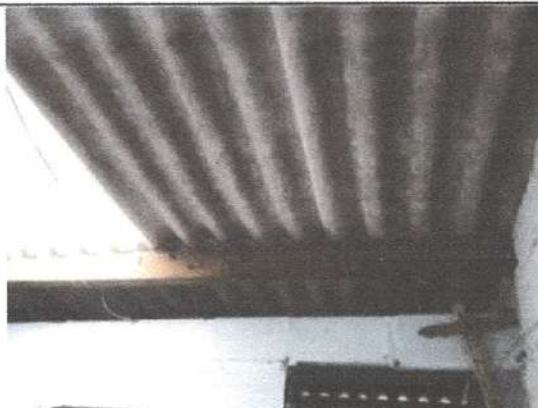
CONSTRUCCIÓN C1 CUBIERTA
