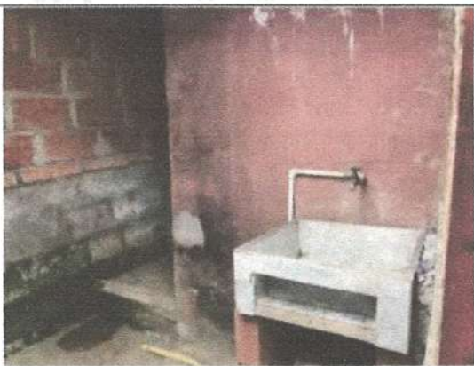
CONSTRUCCIÓN C1 LAVADERO
