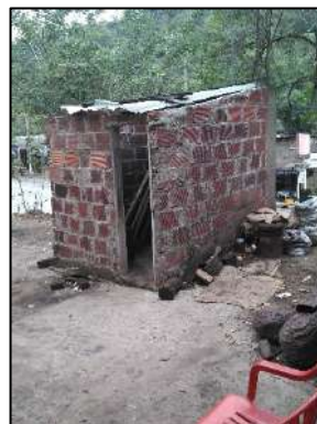
C1-M1 Construcción -bodega
