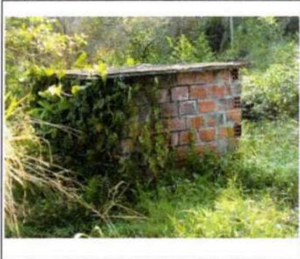
CA-8 CONSTRUCCION EN LADRILLO
