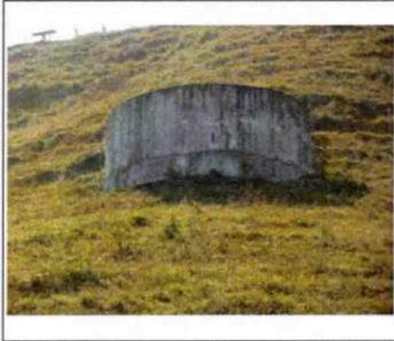
CA-6 TANQUE EN CONCRETO
