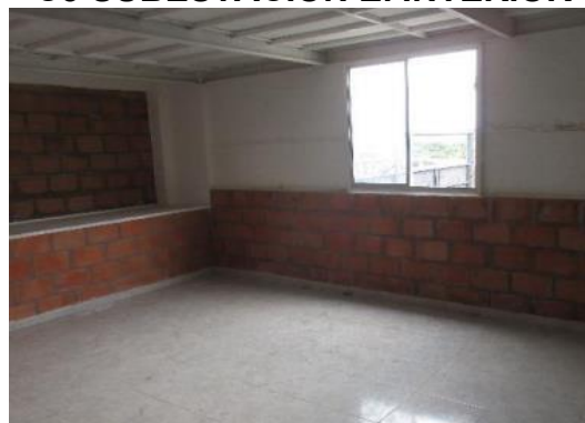
C3 SUBESTACIÓN E. INTERIOR
