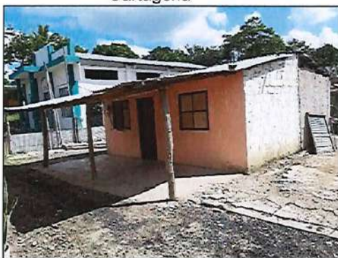
Fachada sobre Carretera Troncal de Occidente
