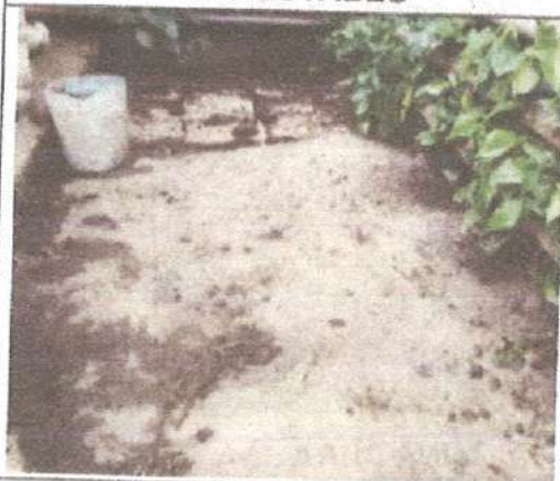
CA10: POZO SÉPTICO
