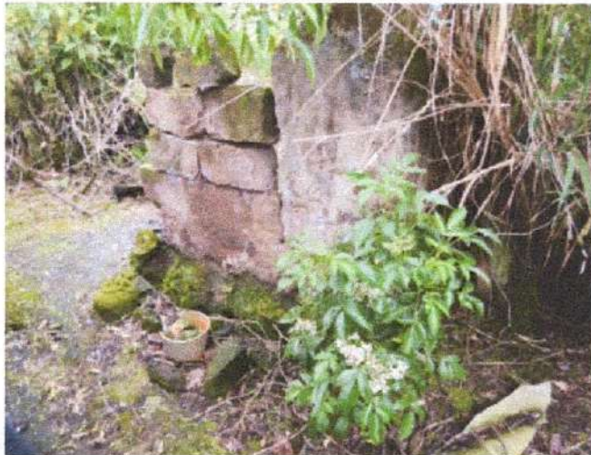
MURO DE CONTENSION
