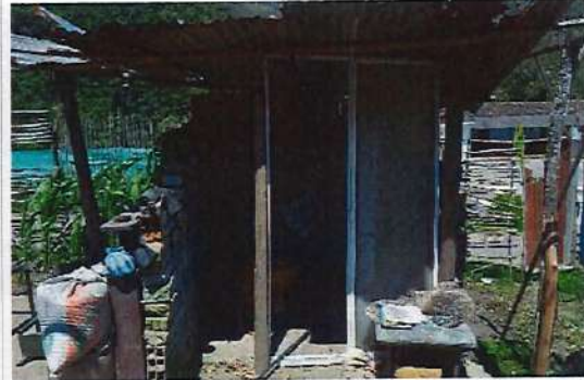
CA14 – ENRAMADA CON CUBIERTA ZINC
