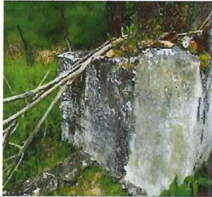
CA7 – BASE EN CONCRETO
