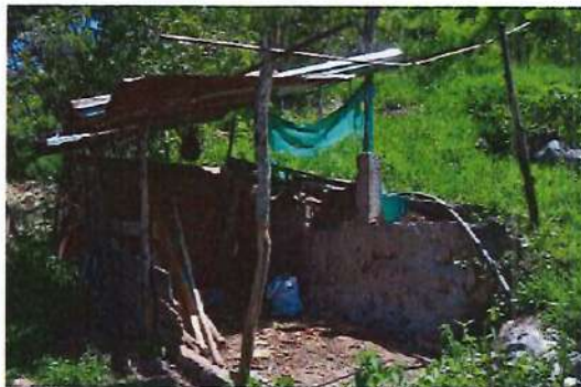
CA9 – ENRAMADA PISO EN CONCRETO
