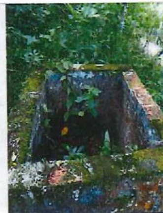
CA – 18 TANQUE EN CONCRETO
