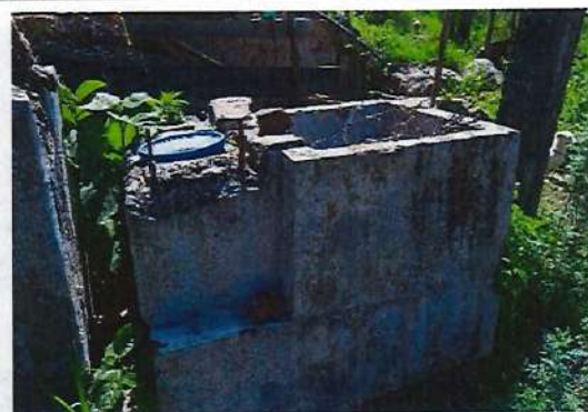
CA6 – TANQUE EN CONCRETO
