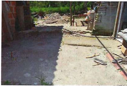
CA19 – ZONA DURA EN CONCRETO
