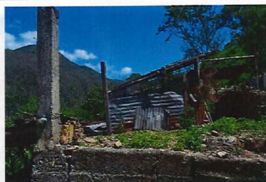
CA5 – ESTRUCTURA SOLO CIMENTOS
