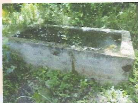
CA5 - TANQUE EN CONCRETO
