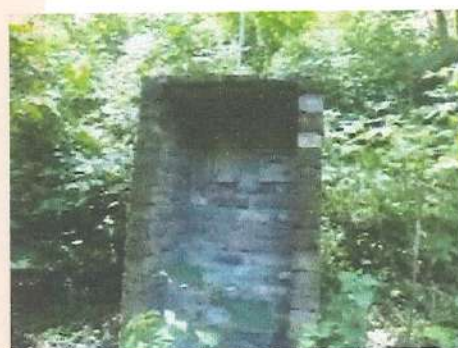
CA3 - CONSTRUCCION EN LADRILLO
