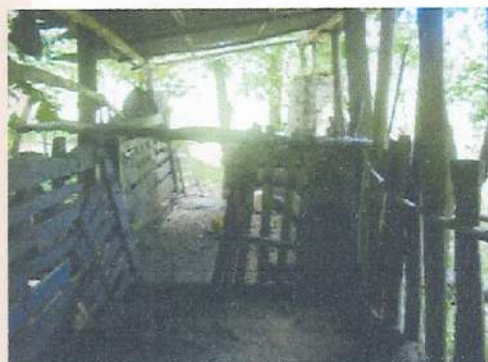
CA2-CORRAL ESTRUCTURA DE MADERA
