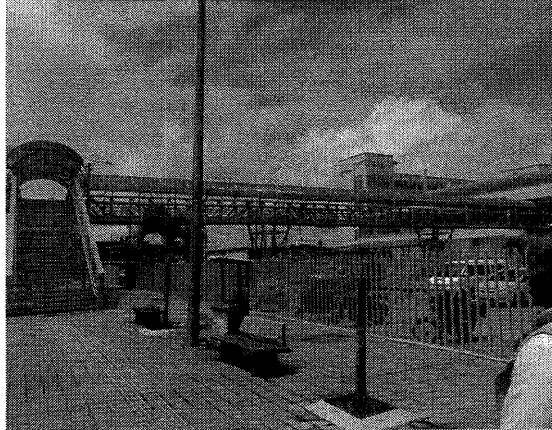
Foto 13. Puente peatonal y centro de servicios aeroportuarios.
