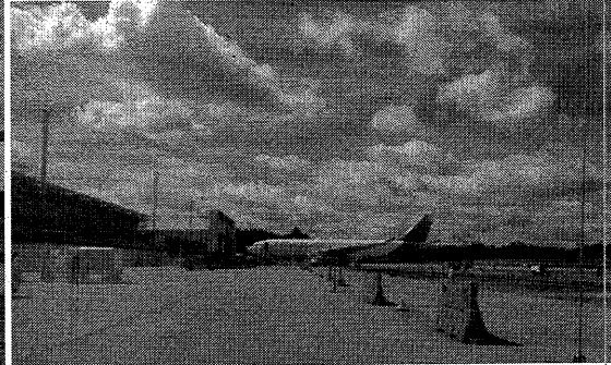
Foto 22. Obras en plataforma del terminal de carga.
