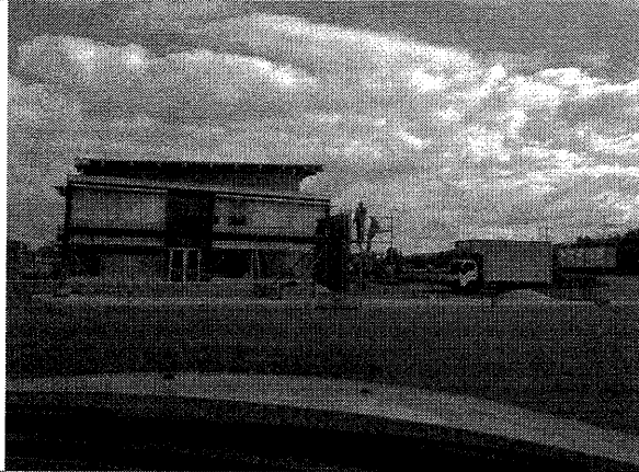
Foto 19. Obras de adecuación del terminal de carga.
