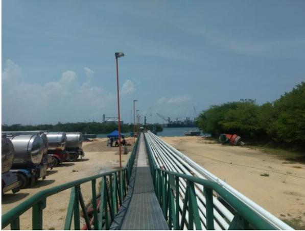
Se verificó la pasarela de acceso a la plataforma de atraque, soportando la línea contra incendios, tubería de transferencia del buque a los tanques de almacenamiento y viceversa, línea de sistema eléctrico y luminarias, según se registra en el inventario.
