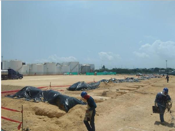
Se verificó la realización de trabajos de protección catódica, para lo cual se observaron excavaciones con el fin de encontrar la estructura del relleno del patio.
