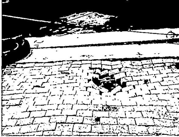
Foto 12. Mal estado del muelle.
